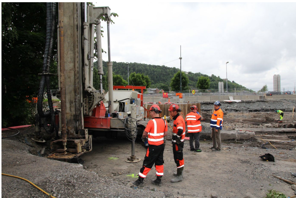
Figur 2: Området for plassering av miljøbrønn M8 før oppstart av borearbeidet. Sett mot sør. Foto: Cf54088_NIKU_01.
