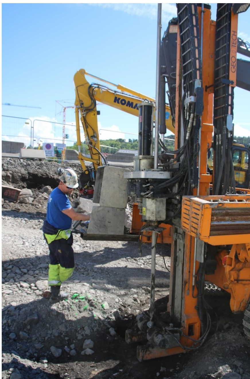
Figur 2: Boring pågår på borepunkt 132. Bilde: Mark Oldham/NIKU.
