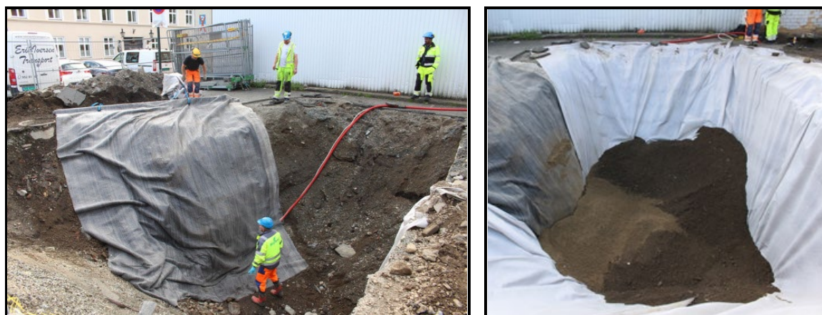
Figur 13. Hull 4 dekkes til med bentonitt-duk, geotekstil og til slutt sand. Foto: NIBIO
