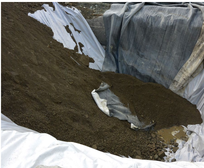
Figur 14. Hull 1 under tildekking med bentonitt-duk, geotekstil og sand. Foto: NIBIO
