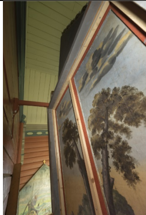
Detaljer fra baksiden. Dørene er festet med lister som er skrudd inn i rammeverket fra 1880-årene
