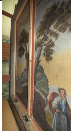
Detaljer fra baksiden. Dørene er festet med lister som er skrudd inn i rammeverket fra 1880-årene
