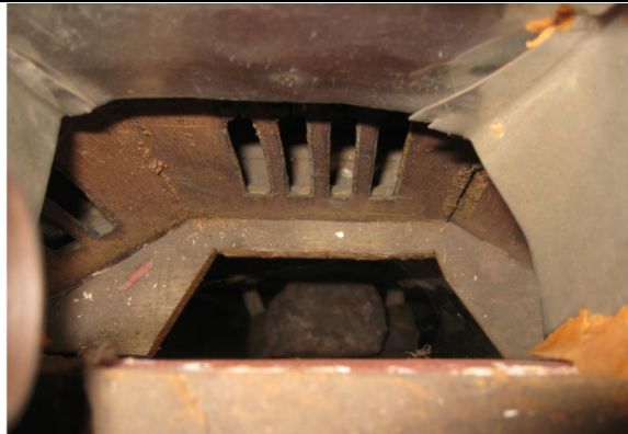
Bildet er tatt ned i ett av hullene og viser at det også er skåret hull i selve baldakinen, over skulpturen. Skulpturens hode skimtes. Øvre del av baldakinen er innvendig kledd med metallplater pga varmen fra lyspæra.
