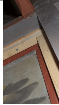
Detaljer fra baksiden. Dørene er festet med lister som er skrudd inn i rammeverket fra 1880-årene
