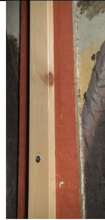
Detaljer fra baksiden. Dørene er festet med lister som er skrudd inn i rammeverket fra 1880-årene
