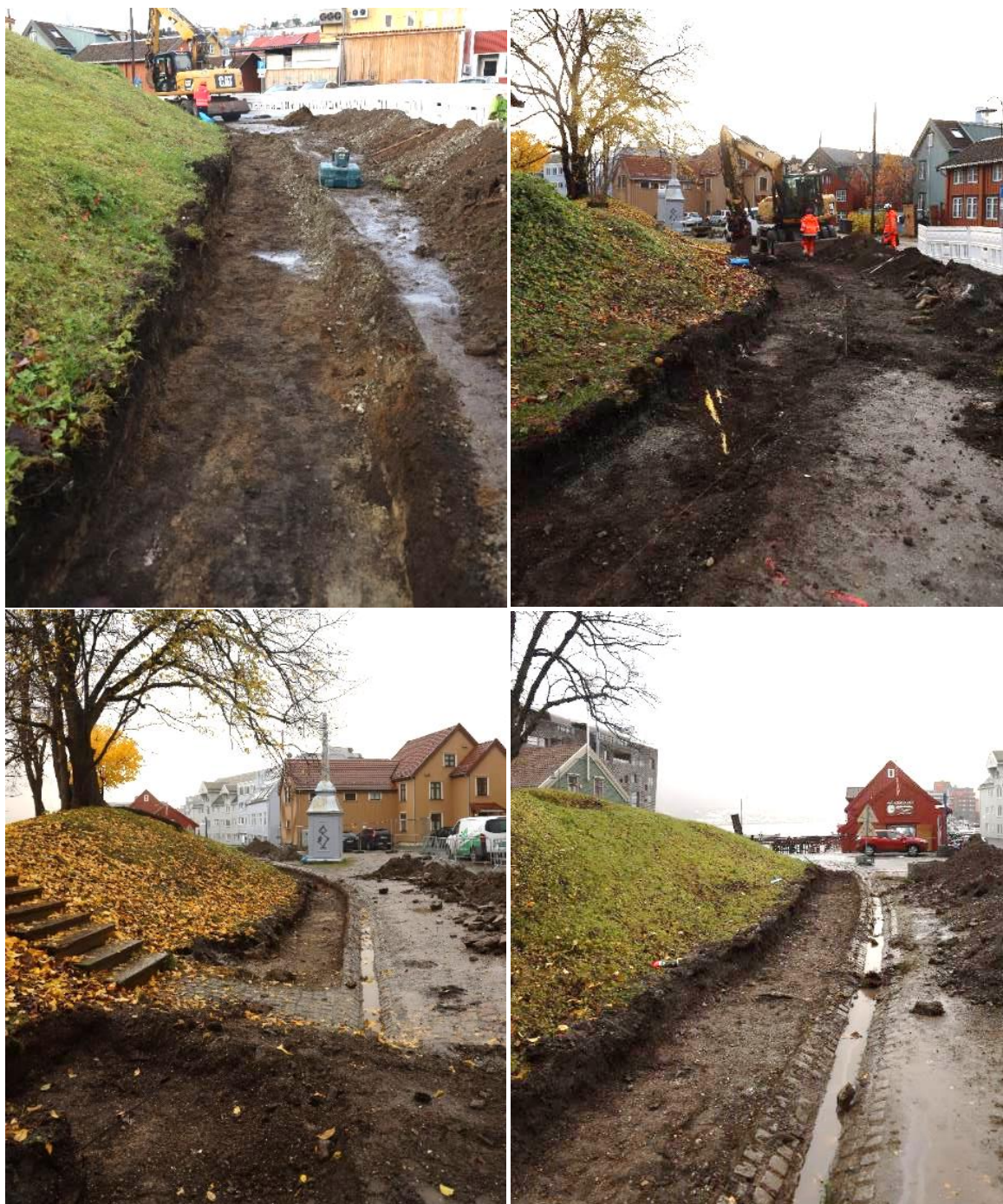
Figur 11: Oversikt over undergrunnen i grøftetraséen langs skifermuren. Foto: Lise Loktu, NIKU.
