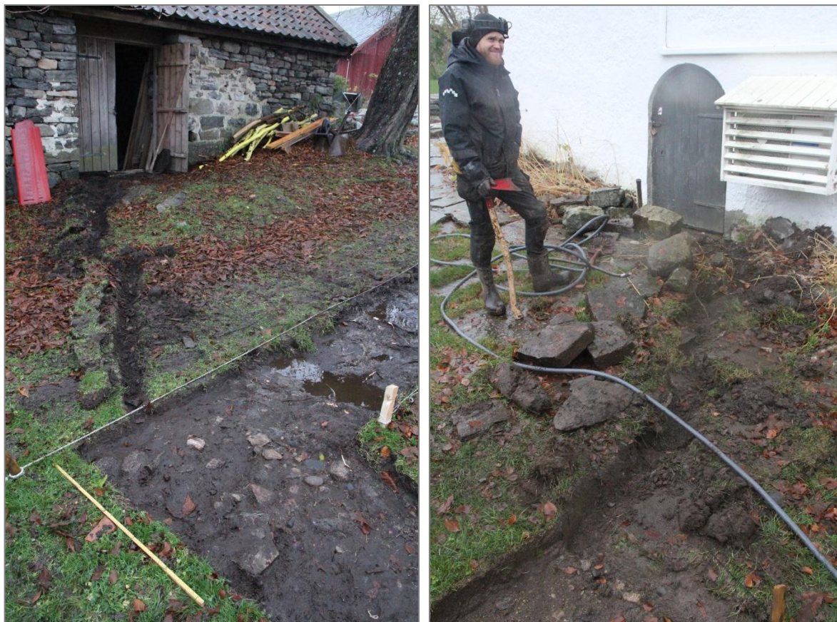
Figur 22A Sett mot nordvest: grøften inn til rom V3.
