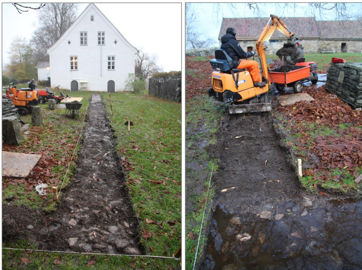
Figur 15A Sett mot øst: steinfyllingen i hjørnet hvor Sjakt Ø-V og Sjakt N-S møtes (Foto RMNIKU 08.11.2022).
