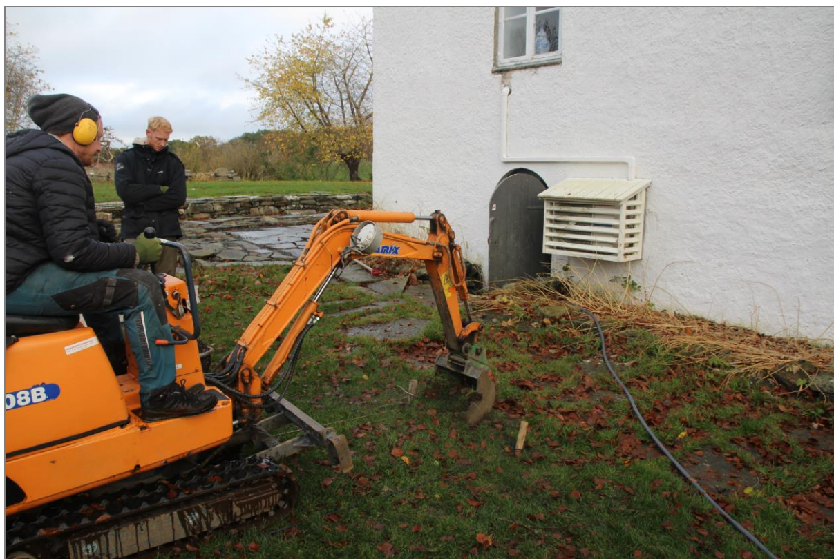
Figur 3 Sett mot nordøst: arbeidet begynte med å ta av torven like utenfor Hovedhusets nordvestre kjellernedgang. Gravemaskinfører på minigraver er her Andreas Remmen Evensen (Foto RM\NIKU 07.11.2022).
