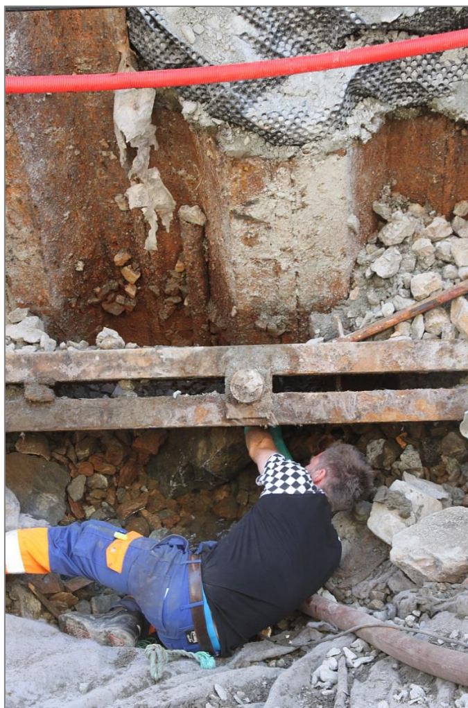
Figur 11: Tetting av staghull (Dunlop, NIKU).
