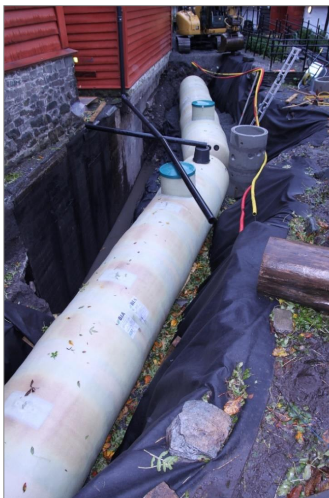
Figur 15: Nedgravde vanntanker, Schøtstuene (Dunlop, NIKU).
