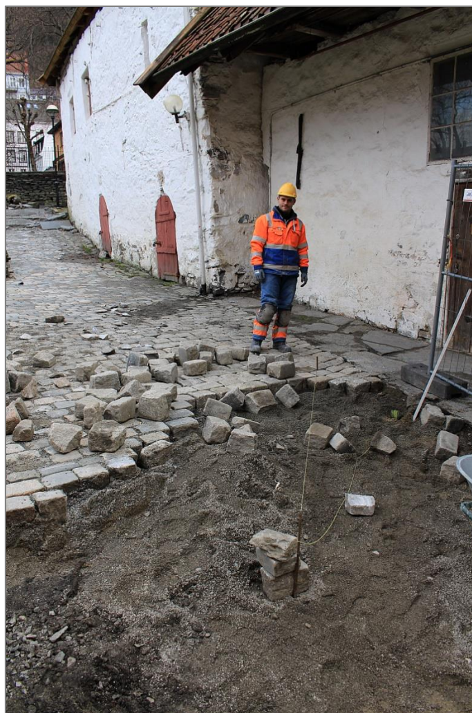
Figur 17: Etablering av permeabel overflate (Dunlop, NIKU).
