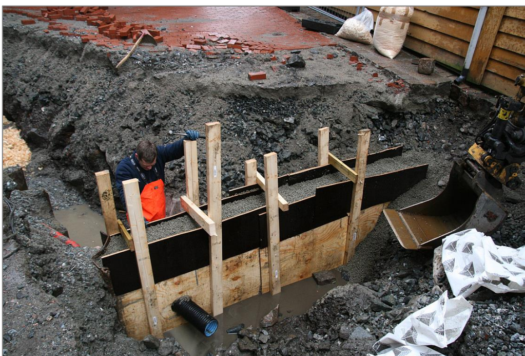
Figur 13: Bentonittdemning, Bryggen (Dunlop, NIKU).
