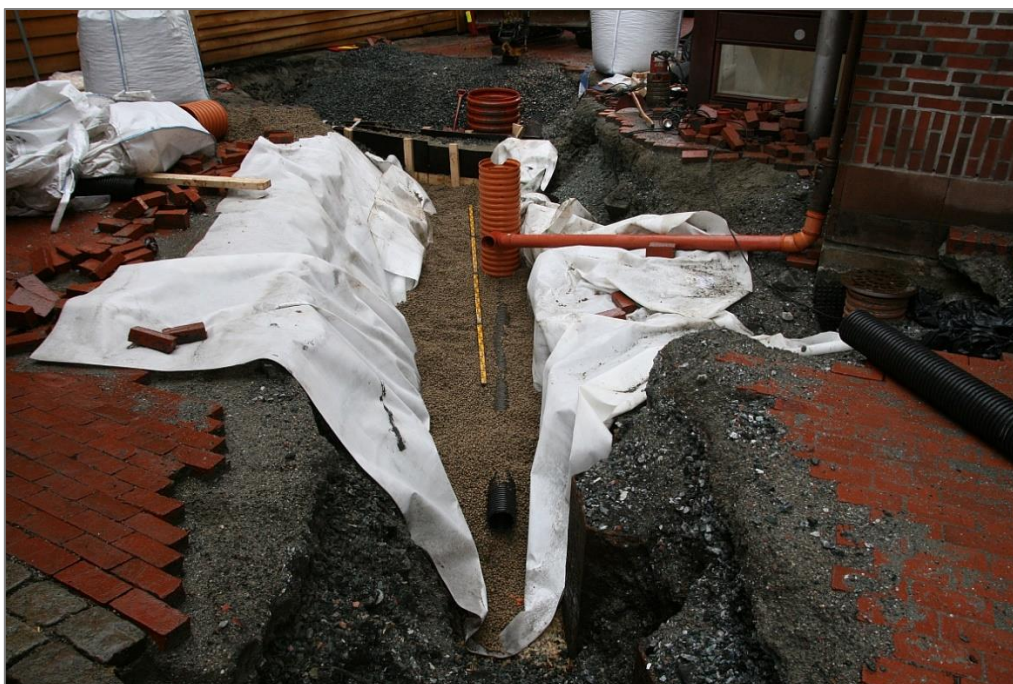
Figur 12: Oppbygging av I/T-grøft, Bryggen (Dunlop, NIKU).
