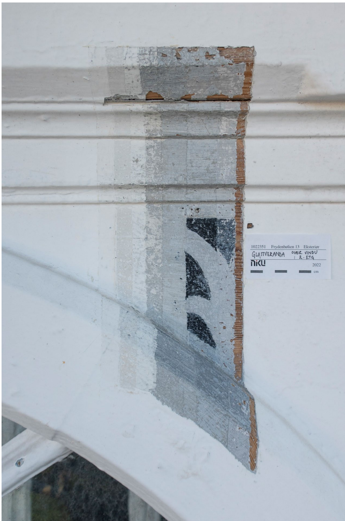
Figur 26 Lagvis avdekning på felt over vindu i glassverandaen. I de to første lagene er det sort sjablondekor på lys bunn (veggfargen). Dekoren har små forskyvninger i de to lagene, men oppfattes som identisk. Dekoren har vært en illusjonsmaling, og har skullet etterlikne løvsagornamentene i glassverandaens gavl. Foto: NIKU, 2022.
