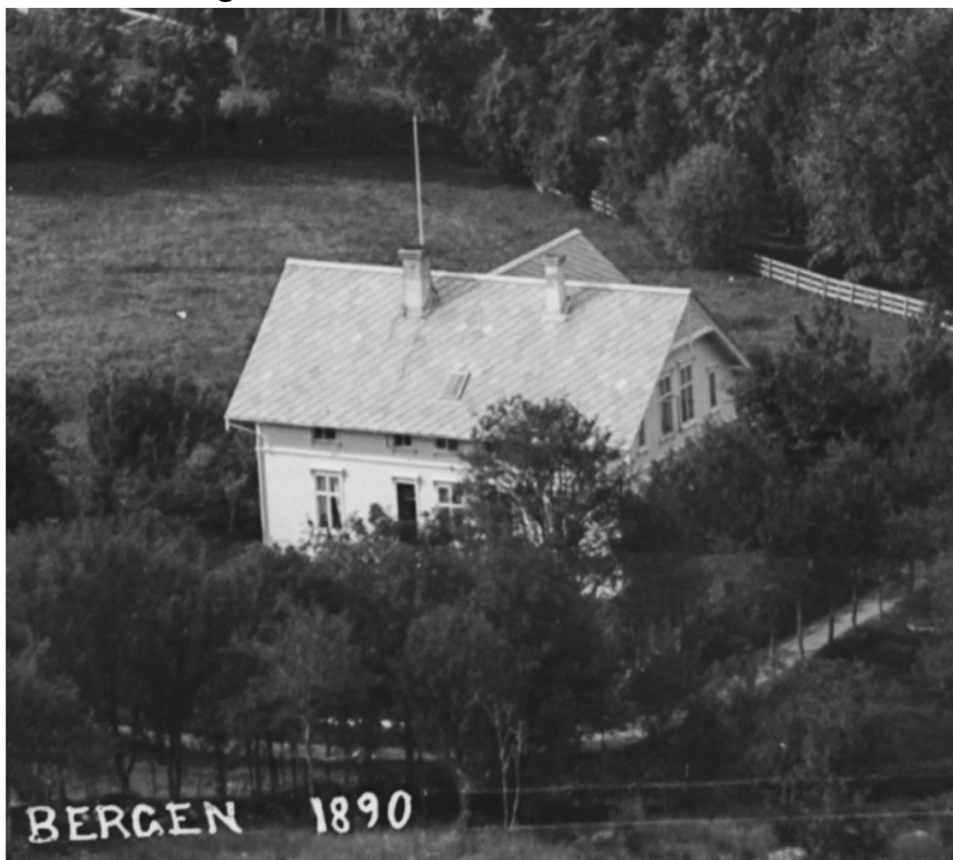
Figur 4 Frydenbølien 13 i 1890. Lys farge på panel og vinduer, mørk farge på dør. Utsnitt fra større foto. Fotograf: Knut Knutsen. Eier: Universitetsbiblioteket i Bergen. Kilde: ubb-kk-2127-1612
