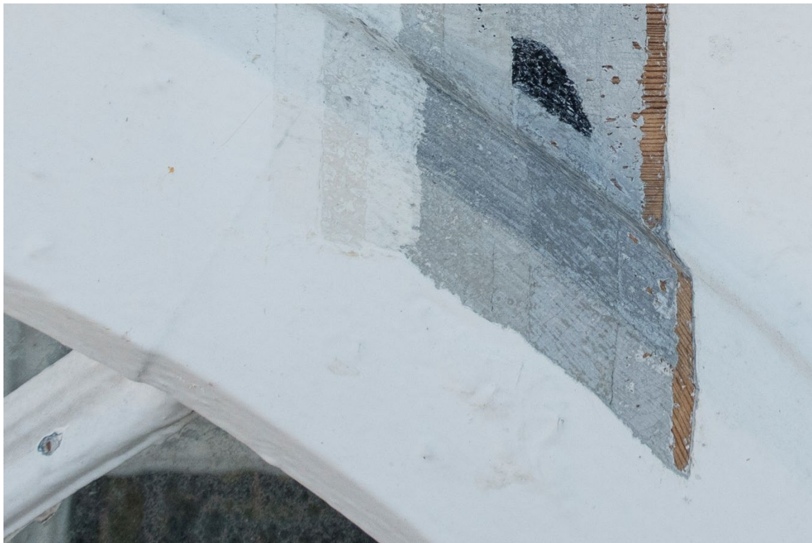
Figur 29 Lagvis avdekning på vindusgerikten i glassverandaen. Avdekningen er i 1. etasje, på vinduet lengst mot øst. På geriktens øvre avfasing og overside er det malt en mørkere fargenyans i de to første periodene. Foto: NIKU, 2022.
