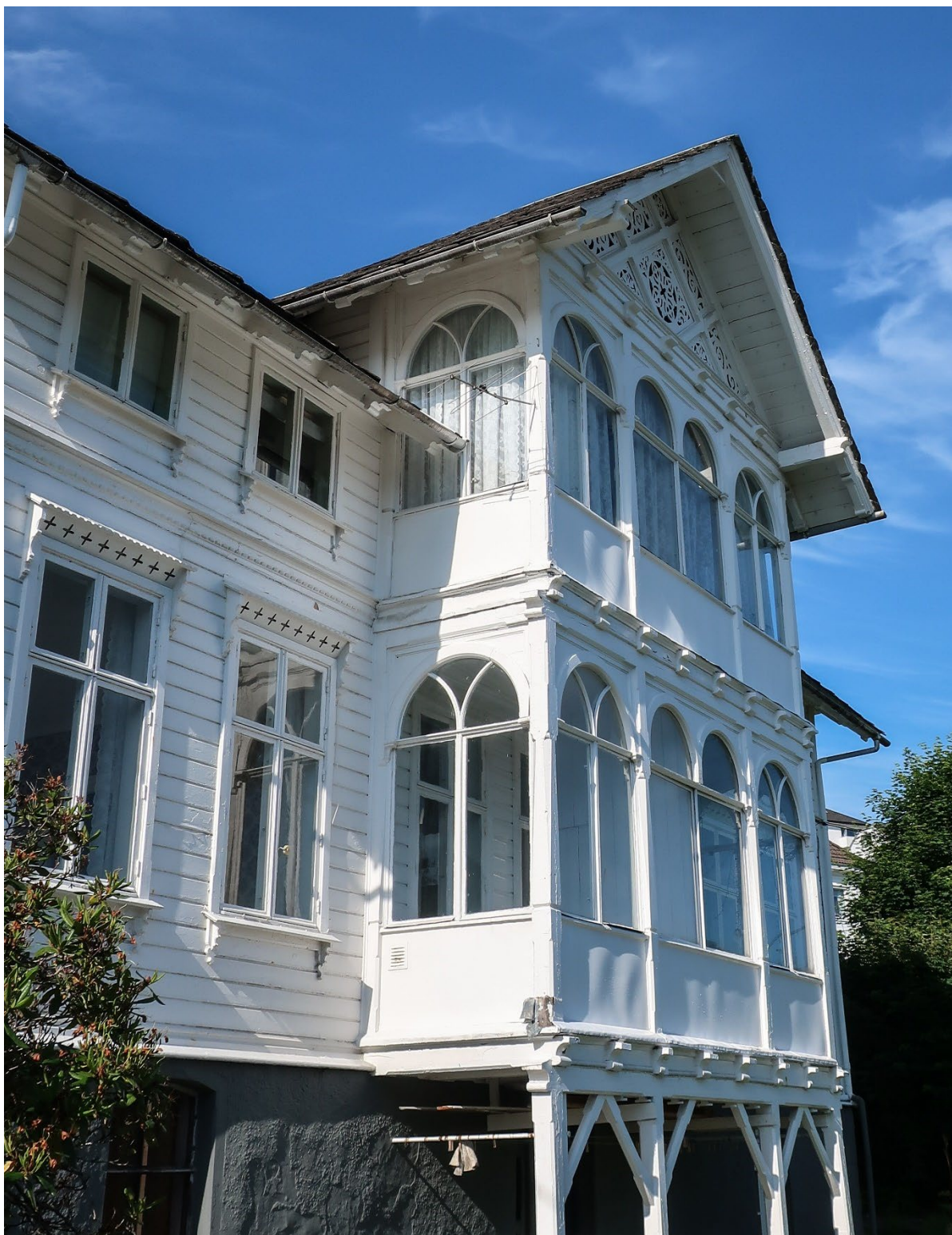
Figur 2 Frydenbølien 13. Nordøstre fasade. Foto: NIKU, 2021.
