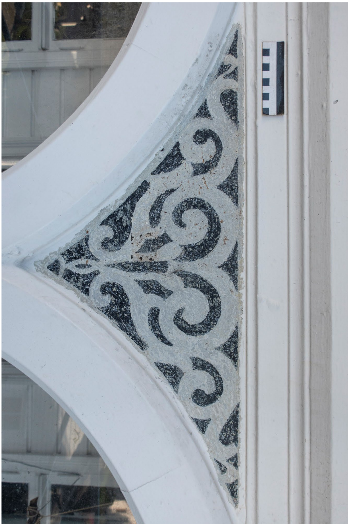
Figur 28 Første lag sjablondekor avdekket i ett helt felt. Bildet er snudd på høykant. Foto: NIKU, 2022.
