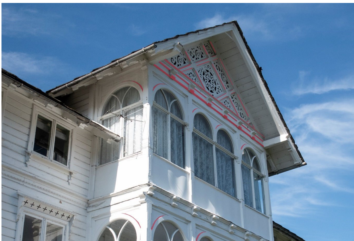
Figur 24 Illustrasjon av hvilke elementer som har vært malt med en mørkere nyanse i de to første periodene. Merk at dette ikke er de opprinnelige fargene. Illustrasjon: NIKU, 2022.
