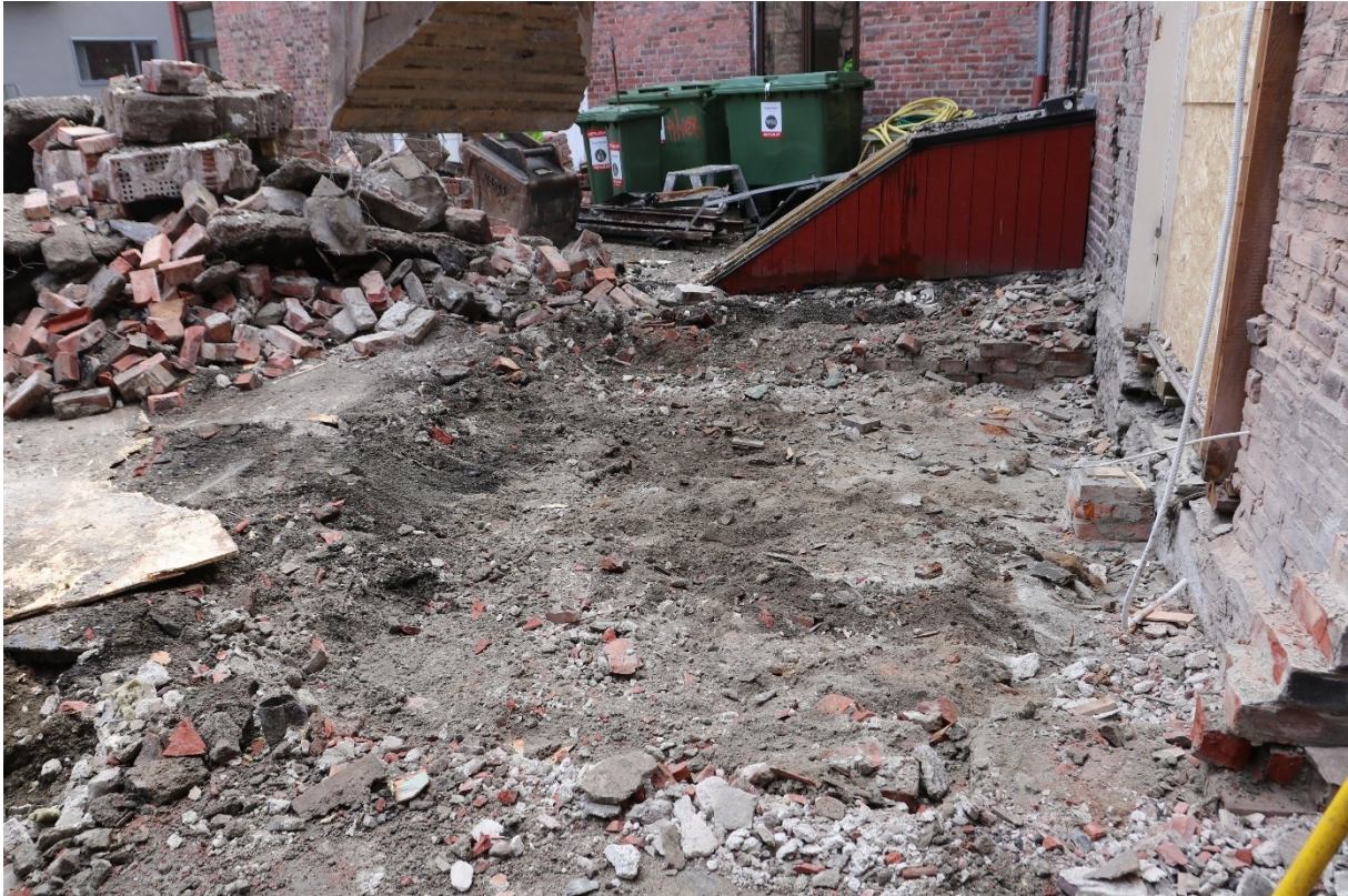
Figur 3. Arealet til den nedrivne bakgårdsfløyen i Munkegata 17. Foto: NIKU.
