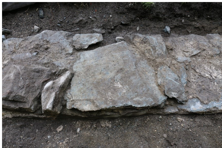
Figur 17. Døme på steinhelle på toppen av den bevarte muren. Sett mot sør. Foto: Da63992_089.
