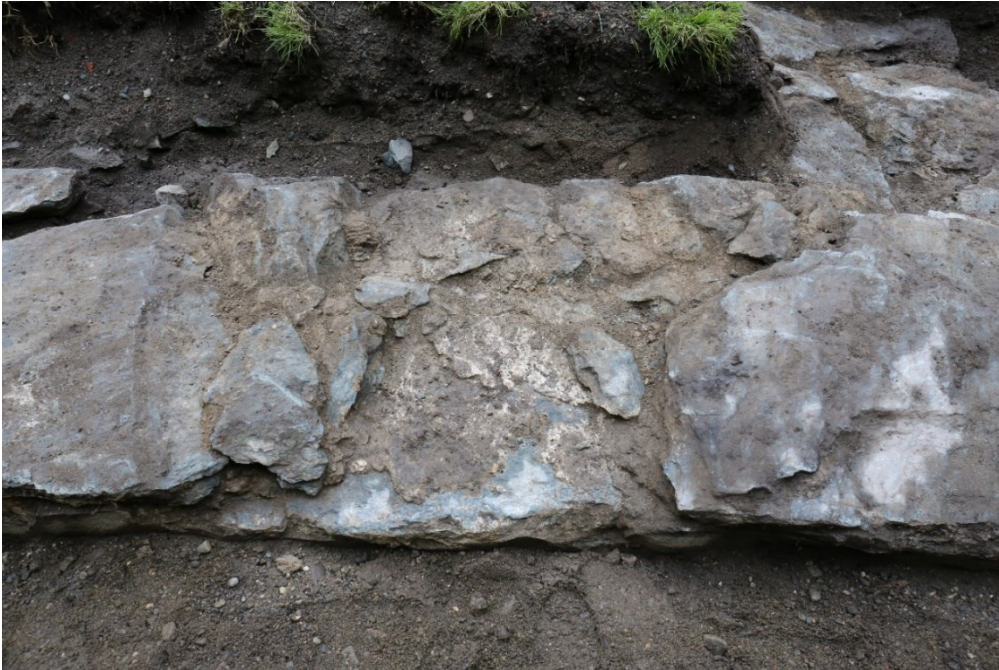
Figur 18. Steinhellene på toppen såg ut til å ligge i kalkmørtel. På denne delen av muren mangla hella i toppen, og ein ser kistemuren under. Sett mot sør. Foto: Da62992_088.
