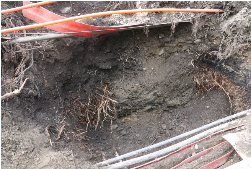
Figur 3. N-S-profilen med grøftekutt og fyll i overgangen mellom den vestre delen av grøfta og austre del. Kulturlag sør og nordaust for grøfta. Da63994_012.
