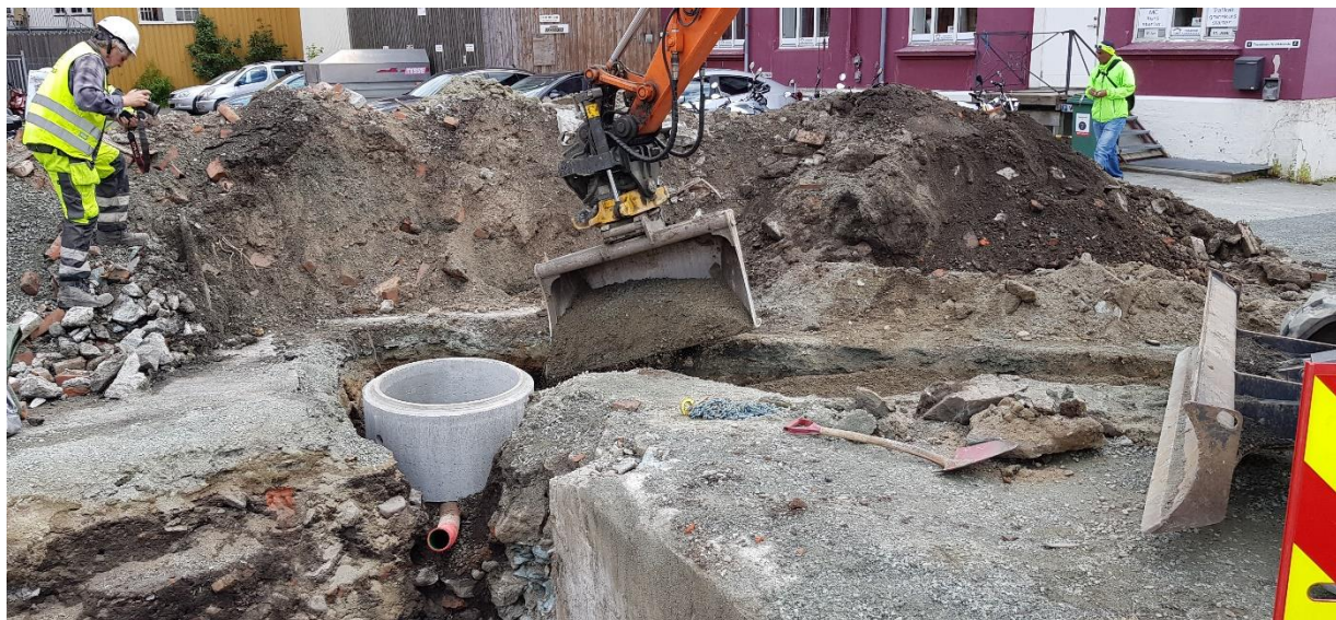
Figur 5: Montering av kum og trekking av rør ved miljøprofil 2
