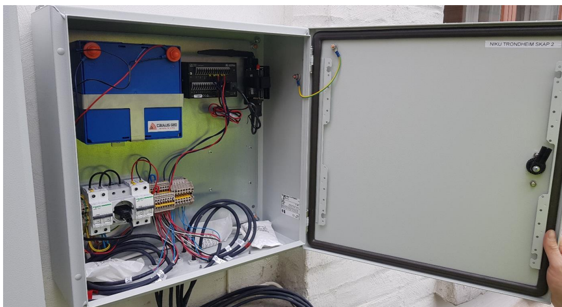
Figur 11. Ferdig montert skap, sett fra innsiden.
