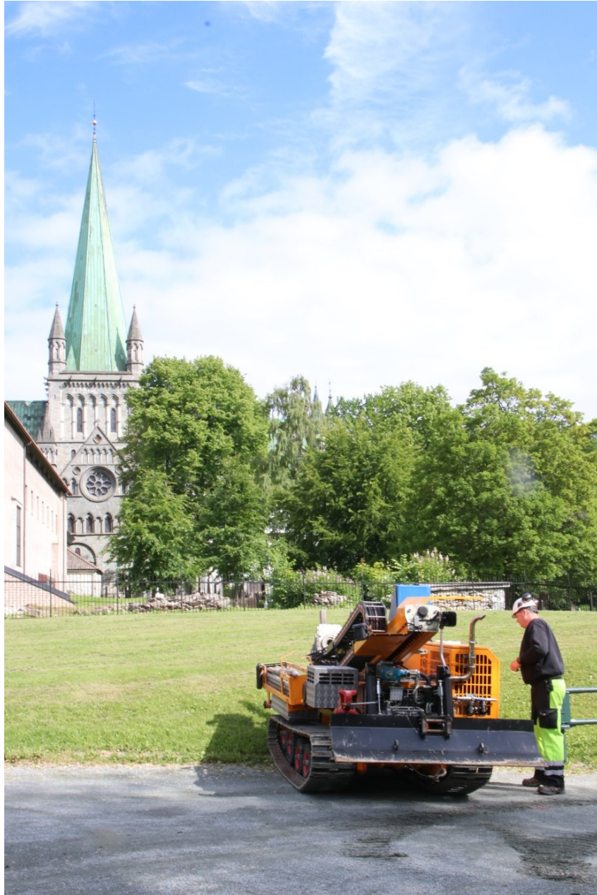
Figur 3. Før prøveboring ved punkt 5, lengst øst. Foto: NIKU.
