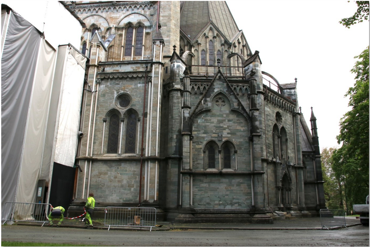
Figur 3. Graving for fundament ved Kongeinngangen i sør.
