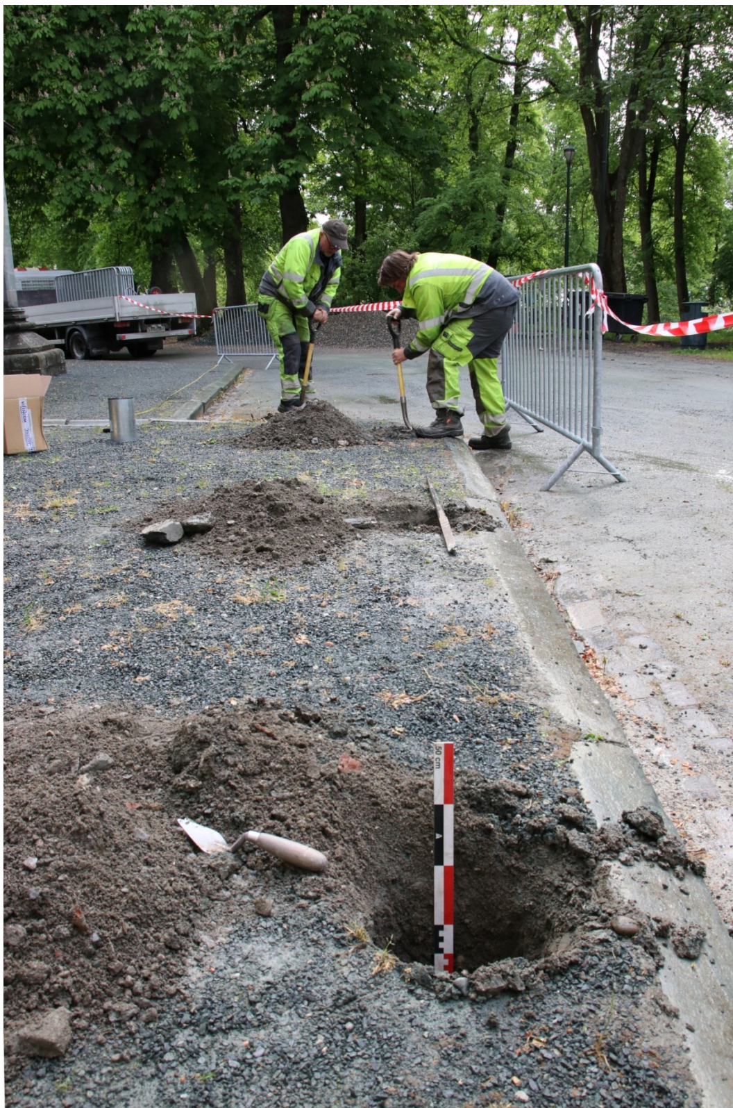
Figur 4. Ferdig gravd hull ved Kongeinngangen, som viser tiltakets gravedybde rundt 0,4 m. Det ble registrert kun moderne løsmasser.
