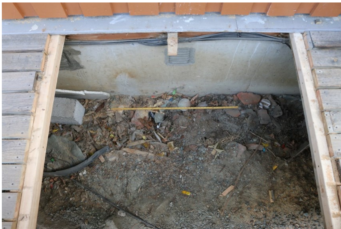
Figur 4. Kutt gjennom svalgangsdekket som viser undersøkelsesområdet. Da63283_NIKU_01.
