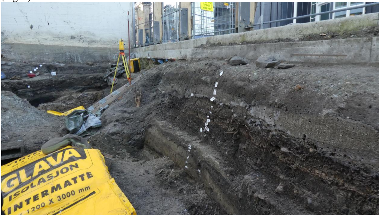
Figur 6. Oversikt over utgravingen rundt profil B i midten sett i (nord)vestlig retning.
