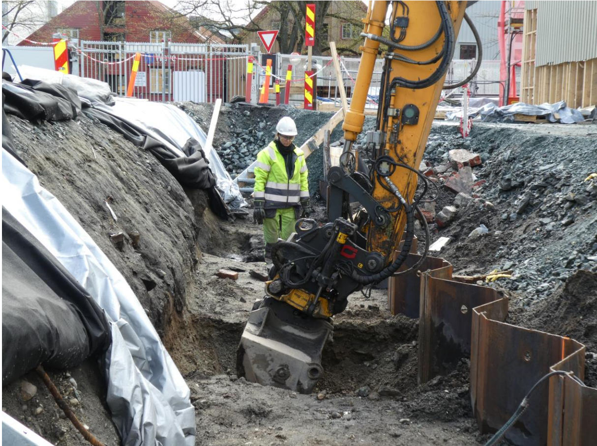
Figur 2. Graving av seksjon 2 i område 2 (Fig. 3). Øverste del av bryggehusene mellom Nidelva og Kjøpmannsgata i øst ses i bakgrunnen.
