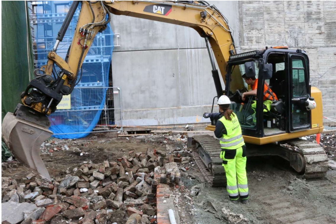
Figur 8: Utgravningsleder Ingeborg Sæhle samarbeider med maskinfører Göran Børseth fra Tverås AS for å få fjernet de moderne massene i tiltaksområdet. Foto: Da62865_3191.
