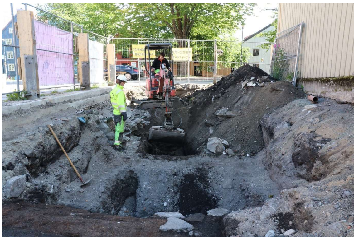
Figur 93: SA386. Kjeller SA386 under utgraving, fyllmasse SL2787 fjernes. Feltleder 1 Synne H. Rostad overvåker maskinen, ført av Göran Børseth (Tverås AS). Til venstre ses hvelvkjeller SA385. Da62865_0219.
