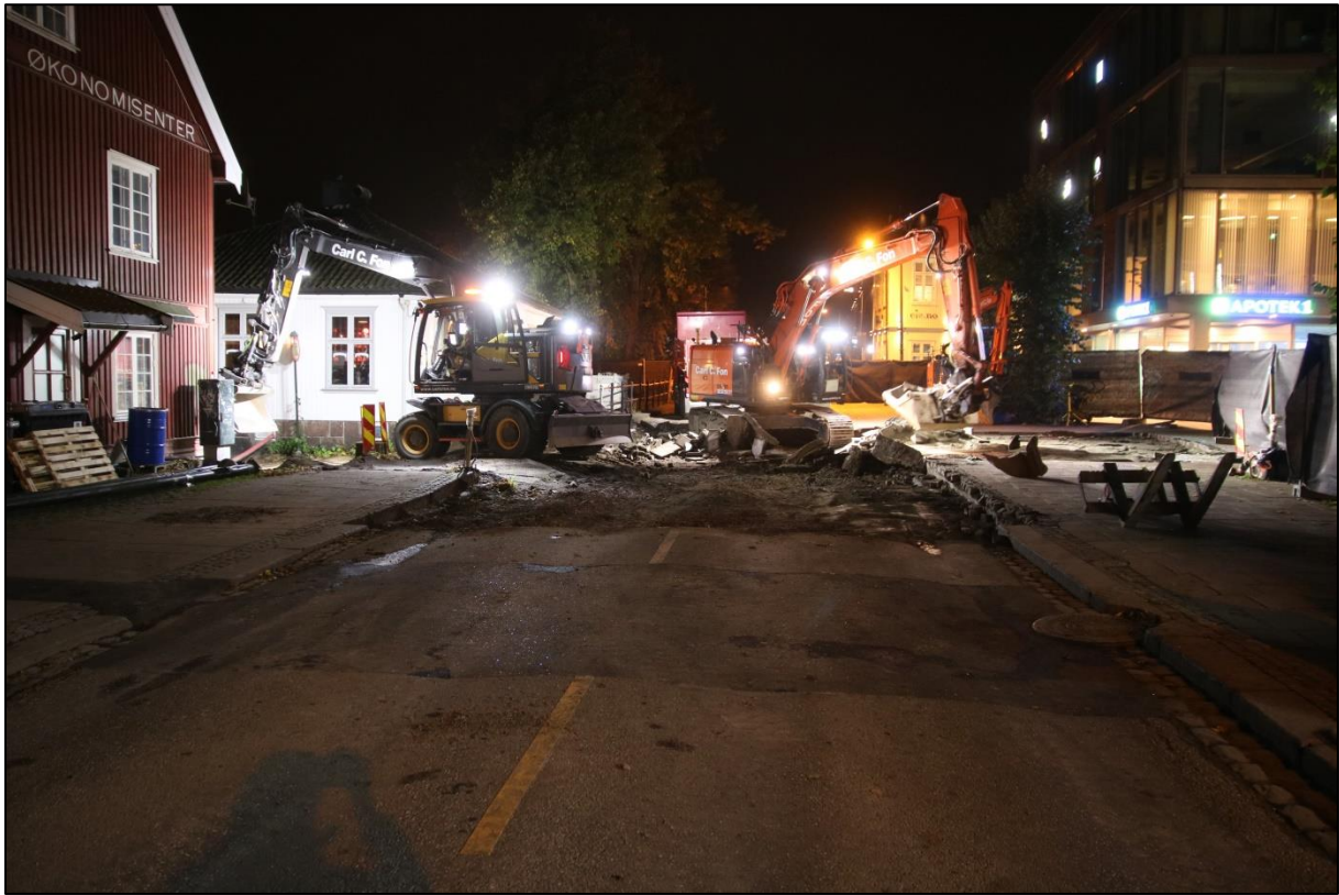
Figur 3. Sone 1. Sett mot NV. Cf53894_NIKU_875098.
