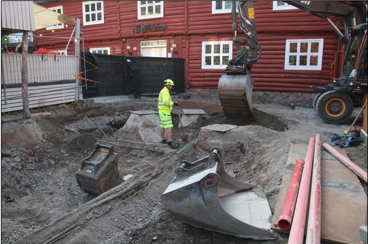
Figur 33. Sone 3, SV-del. Avdekking av kummer og ledninger med Frode Stentun fra Carl C. Fon (med tillatelse). Sett mot Ø. Cf53894_NIKU_874900.
