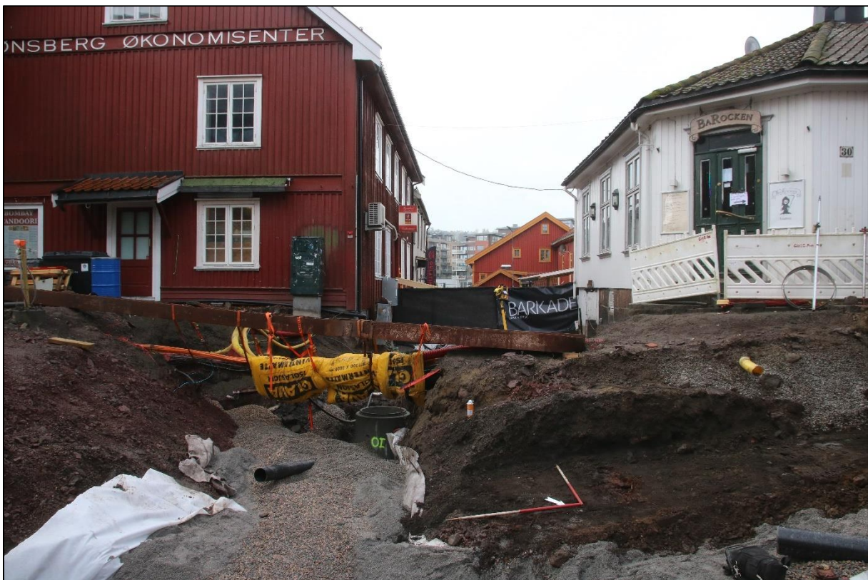
Figur 19. Bygning SA18537 til høyre. Sett mot SV. Cf53894_NIKU_875267.
