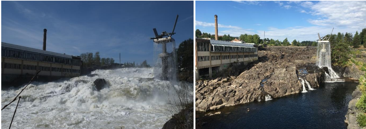
Hønefossen med og uten vannføring (NIKU mai/juli 2018)
