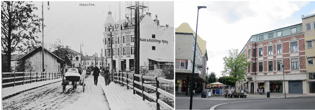
Thisted-gården i Fossveien 1 rundt 1900, sett fra brua - med tårn og telegrafantenne på taket (kilde) og i 2018 (NIKU).
