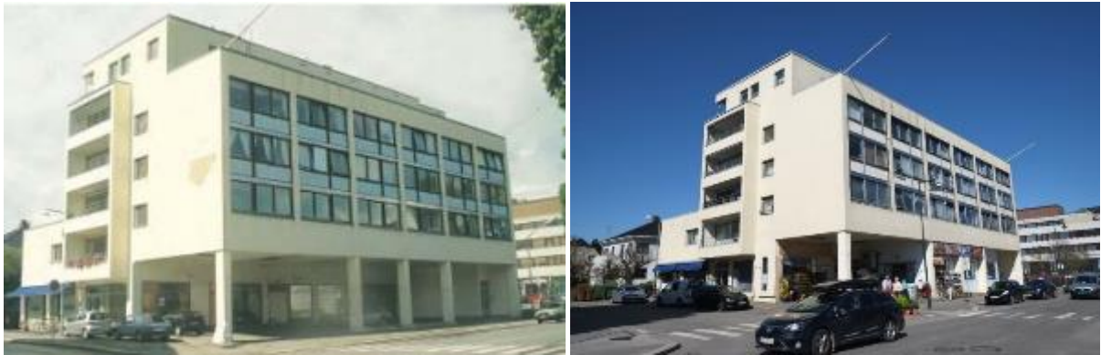
Figur 5 Karlsen-gården fra 1957, med overbygget uteareal for inn og utkjøring til bensinstasjon og Karlsen-gården i dag med noe av første etasje innebygget (NIKU 2018)
