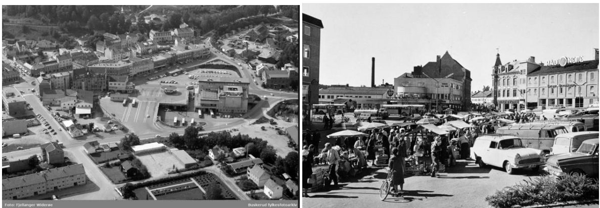
Bildet til venstre viser Rutebilstasjonen på rutebilplata Hønefoss med samfunnshuset fra 1964 til høyre i bildet. Til høyre er rutebilstasjonen sett mot Søndre Torg på 1960-tallet. Thistedgården og Møllegården i Fossveien til høyre. (digitalt museum)
