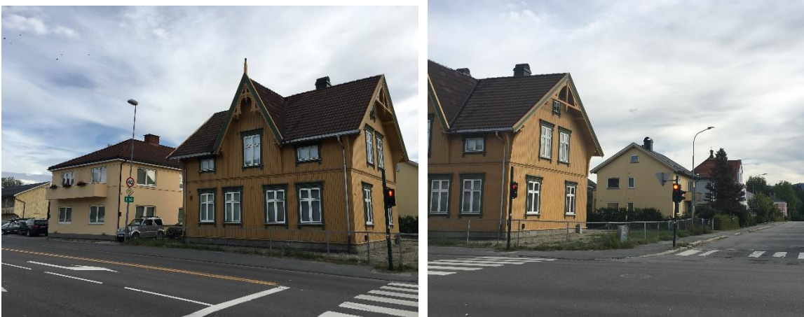
Kongens gate 10 og 12 og Kongens gate 12 som del av villarekken langs Kong Rings gate (NIKU 2018)
