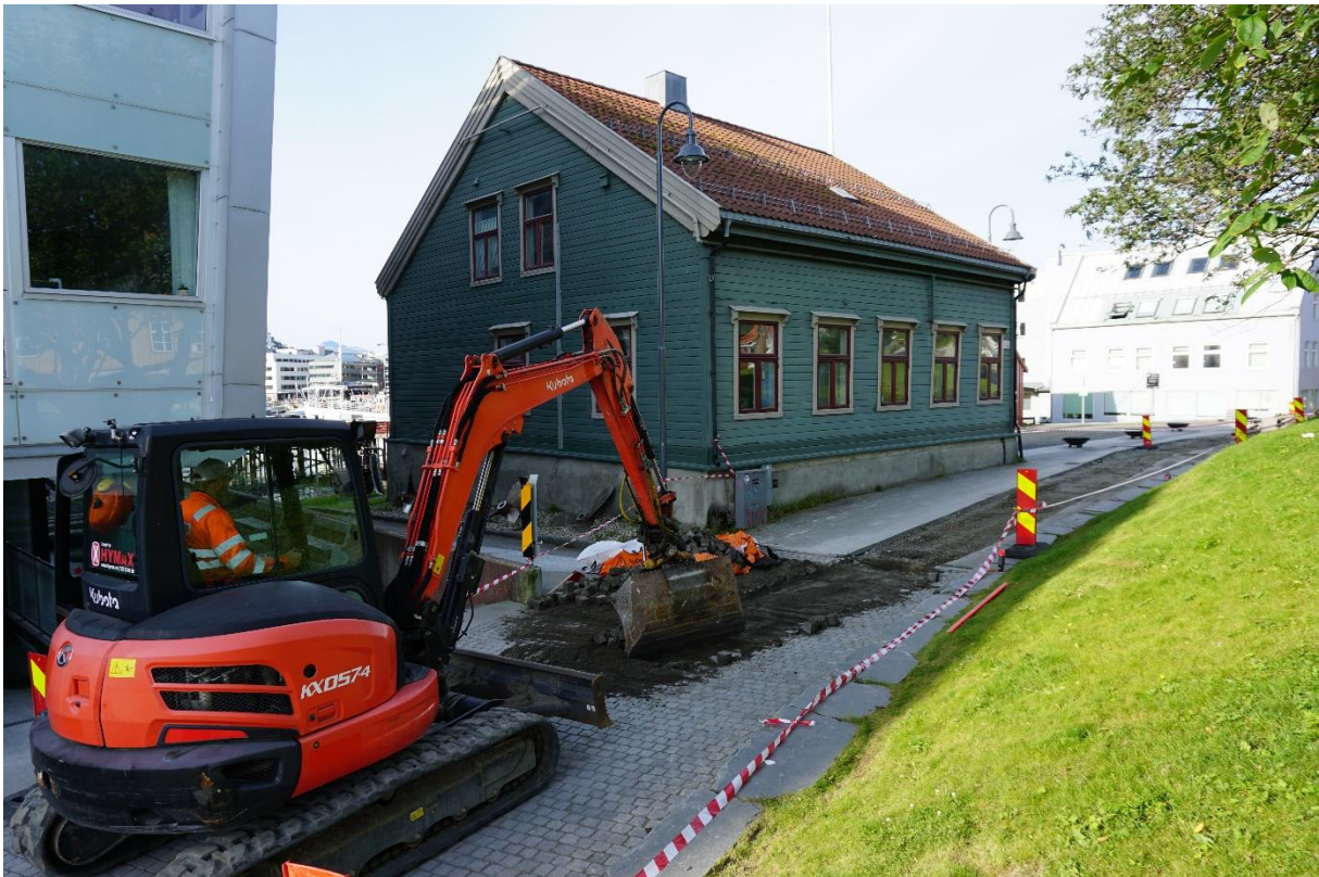
Figur 3: Oversikt over tiltaksområde mellom Tollbodgaten 13 og 11 etter fjerning av asfalt sett fra sørlig del av Skansen. Foto: Alma Thuestad, NIKU.
