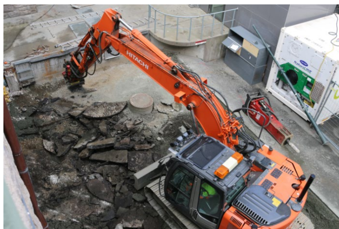
Figur 4. De første dagene i felt gikk med til å fjerne asfalt og moderne forstyrrelser. Sett mot nordvest. Da_62840_001.
