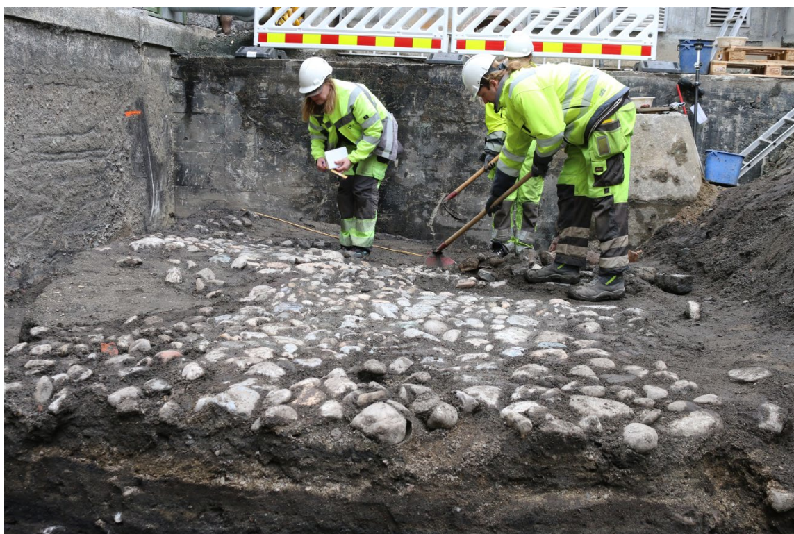
Figur 8. Alle lag under brosteinsdekket på bildet ble gravd ved hjelp av spade, graveskje og krafse. Sett mot vest. Da_62840_032.
