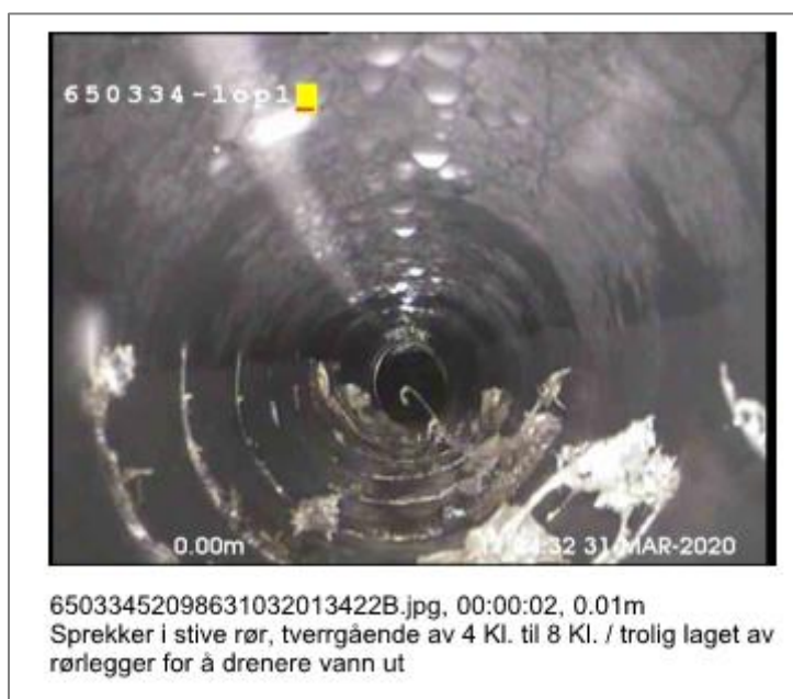
Figur 11. Inspeksjon av I/T ledning. Vitek AS
