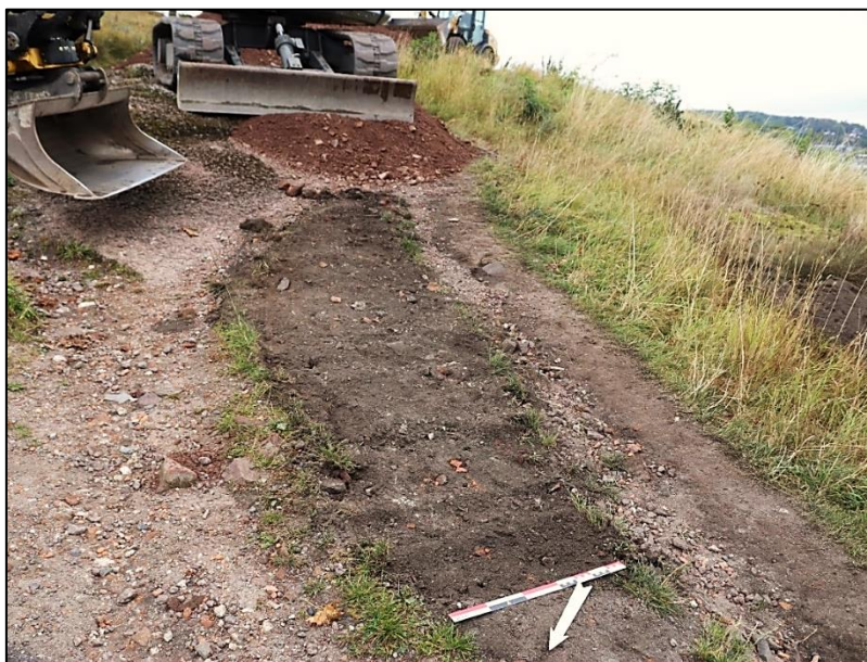
Figur 3. Cf54075_NIKU_0037 Oversikt mot nord. SK23150
