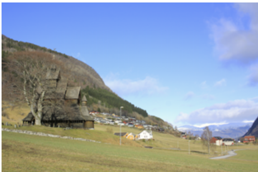
Illustrasjon 1. Hopperstad stavkirke sett sørfra, med utsikt mot Vikøyri og Sognefjorden. Foto: forfatteren.
