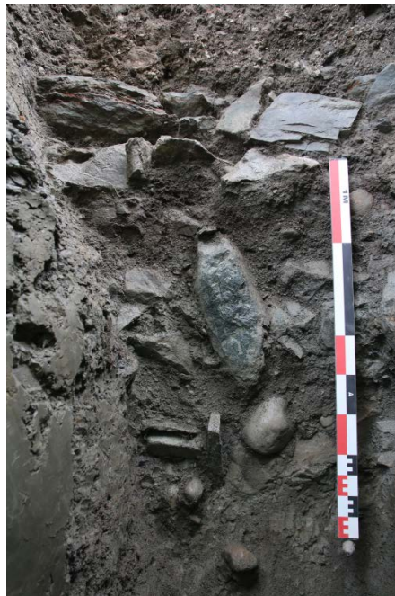
Figur 95: Fundamentet er bygd opp i flere nivåer. Profilbilde 5d. Sett mot sør. Da62836_820.
