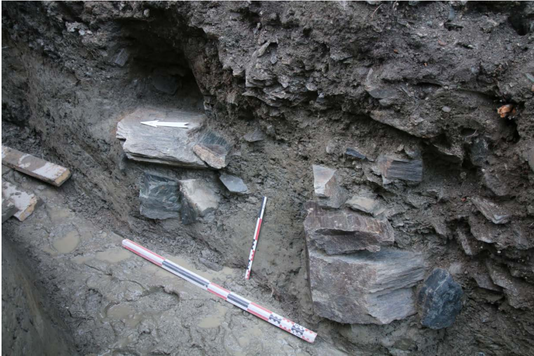
Figur 195: Nærbilde av fundamentene 3511 (venstre) og 3489 (høyre). Sett mot øst. Da62836_565.
