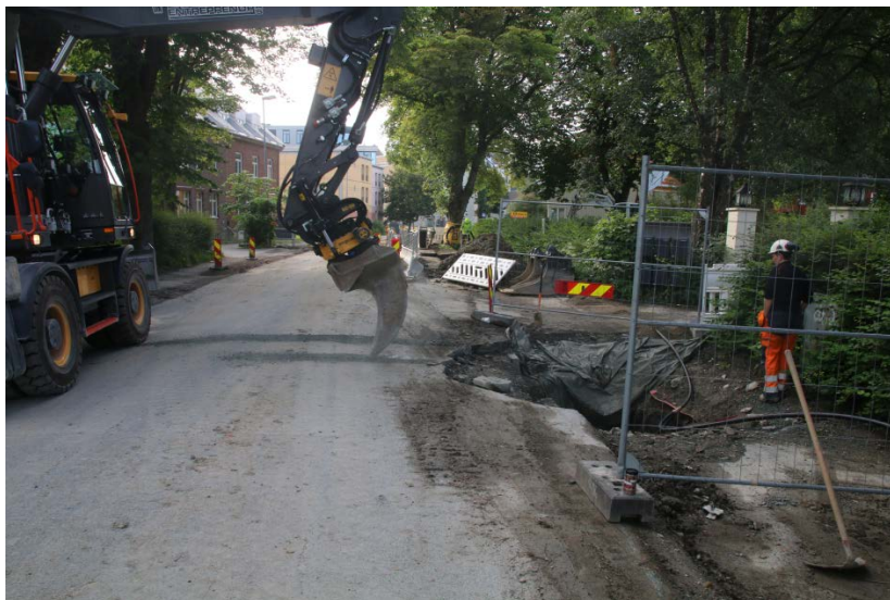
Figur 43: Åpning av sjakt 11. Sjakt 4 ses til høyre i bildet. Sett mot sør-øst. Da62836_468.
