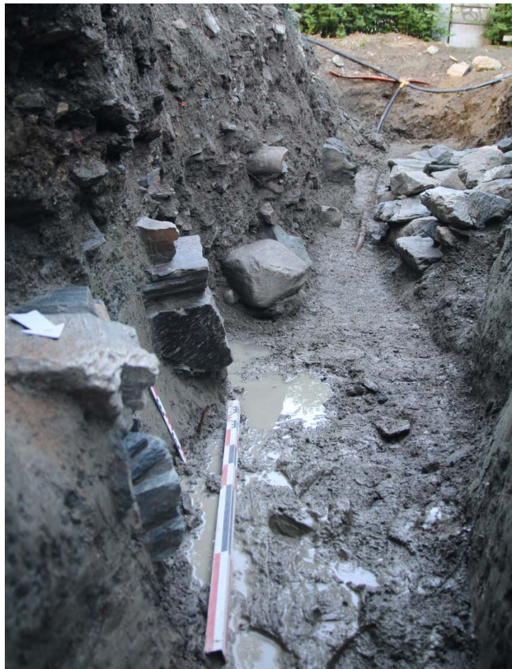
Figur 196: Fundamentene 3511 (nærmest kamera) og 3489 med fundament 2808 i bakgrunnen. Sett mot sør-vest. Da62836_569.
