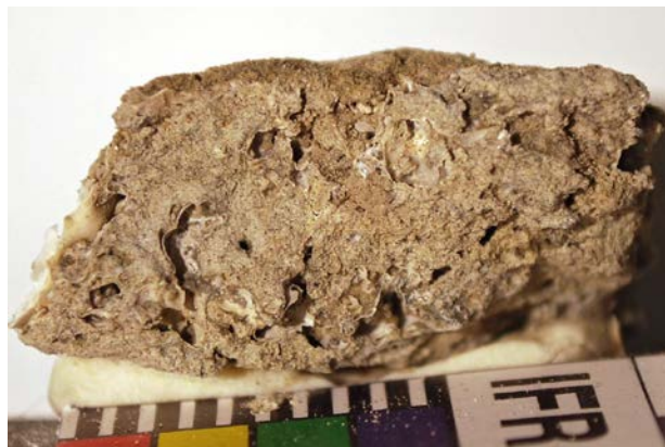
Figur 68: Flere mørtelrester ble analysert av Per Storemyr ved Fabrica Kulturminnetjenester AS. Her ses en forstørret mørtelbit. På denne måten kan en si noe om hvordan mørtelen ble laget. Foto: Per Storemyr.
