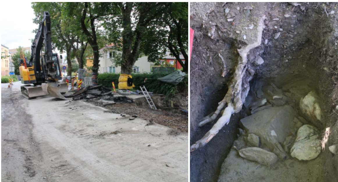
Figur 10: Røtter fra de store trærne langs Klostergata bød på problemer når det kom til graving av påkoblingshullene. Venstre: Stort tre med røtter som gikk dypt ned i sjaktene 5 og 6. Høyre: Røtter over strukturer i sjakt 6. Da62836_798 og Da62836_095.
