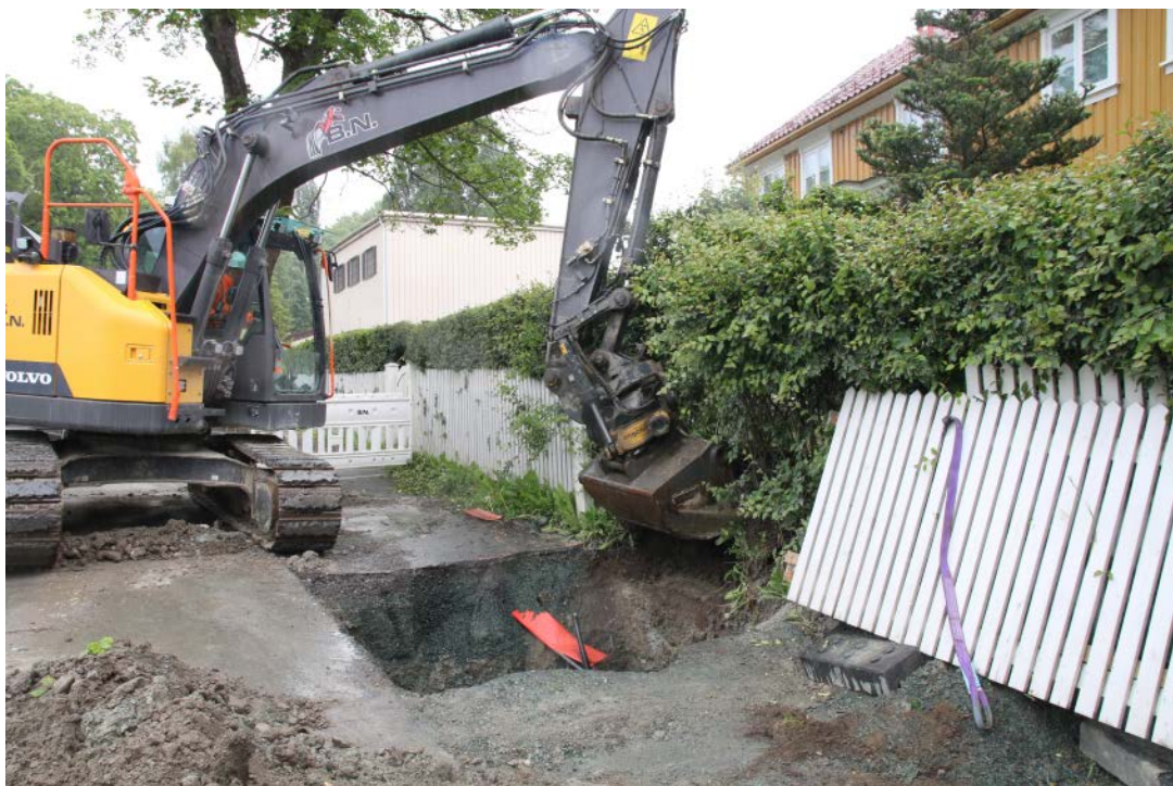
Figur 8: Hovedvannledningen befant seg i noen tilfeller inne på tomtene til eiendommene i Klostergata. I dette tilfellet under hekken til Klostergata 51. Sett mot sør-øst. Da62836_261.
