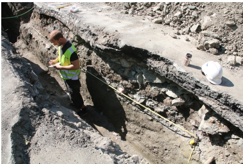
Figur 45: Sjakt 12 var så smal at det ble valgt å tegne profilen i tillegg til å ta bilder. Sett mot sør-vest. Da62836_681.
