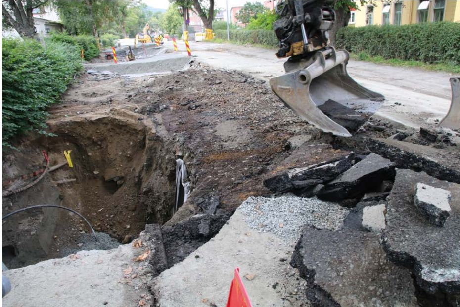
Figur 27: Sjakt 5 ble utvidet mot nord i uke 34 for å undersøke fundamentene observert i den nordre profilen. Disse befant seg under den grå filtduken midt i bildet. Sett mot nord-vest. Da62836_796.
