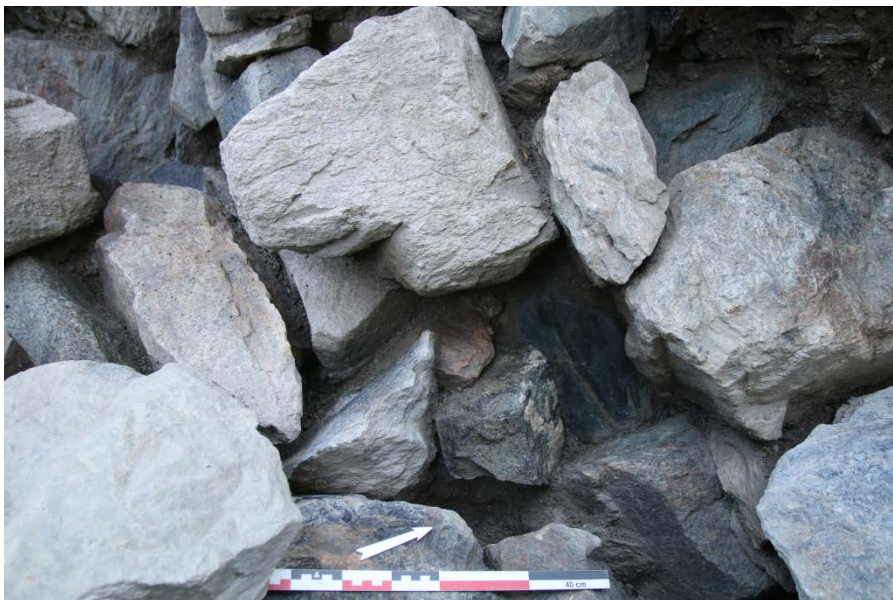
Figur 193. Noen av steinene i fundament 2808 hadde mørtelrester og var bearbejdet; muligens gjenbrukt, kanskje fra en eldre kirke? Innslag av kleberstein fantes også. Sett mot nord-vest. Da62836_574.
