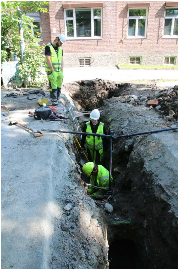
Figur 9: Fire stikkledninger som strakk seg over Klostergata ble gravd (9, 11, 12 og 14). Her undersøkes profilen på sjakt 9. Sett mot nord-øst. Da62836_422.
