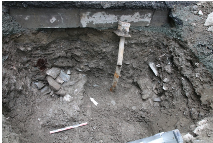
Figur 4: Påkoblingspunkt til hovedvannledning midt i bildet. Bildet er tatt i sjakt 4. Sett mot nord-øst. Da62836_024.
