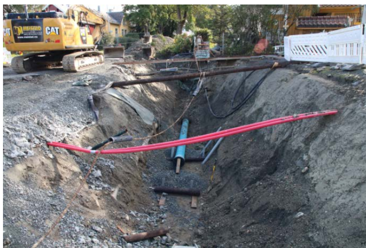
Figur 14: Den planlagte utblokkingen av hovedvannrøret bød på problemer for entreprenøren. Her ses sjakt 8 utvidet mot sjakt 1 for å få bedre tilgang på vannrøret. Sett mot sør-øst. Da62836_955.
