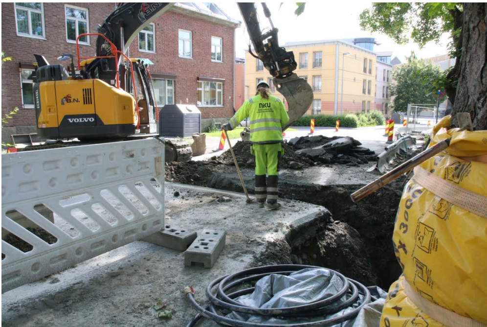
Figur 12: Ved graving av de kryssende stikkledningsgrøftene ble Klostergata stengt for trafikk. Her ved graving av sjakt 9. Sett mot sør-øst. Da62836_401.
