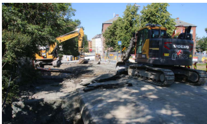
Figur 51: En CAT 326F L på 26 tonn og en Volvo ECR145E L på 16 tonn ble brukt i undersøkelsen. Sett mot nord-vest. Da62836_726.
