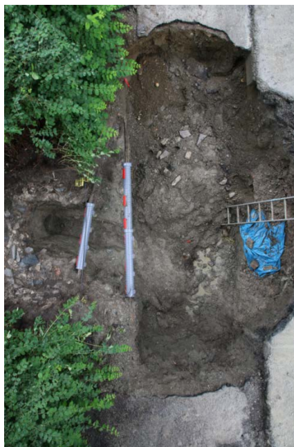
Figur 30: Til venstre i bildet ses den nord-sør orienterte stikkledningen som går fra hovedvannledningen og inn i hagen til Klostergata 47. Denne ble dyttet inn under en bolk med kulturlag (helt til venstre) pga. et steingjerde som sto her. Sett mot nord-vest. Da62836_335.
