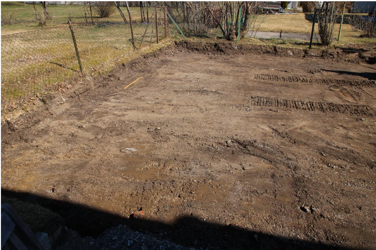
Figur 4: Ferdigstilt gravd grop for nytt fundament. Målestokk viser 1 meter. Sett mot nordøst. Foto: Cf53863_NIKU_11.
