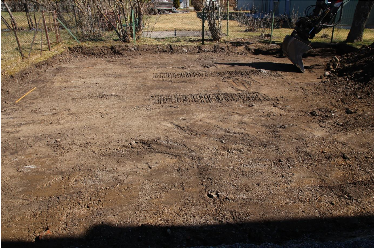
Figur 5: Ferdigstilt gravd grop for nytt fundament til garasje. Målestokk viser 1 meter. Sett mot øst. Foto: Cf53863_NIKU_12.
