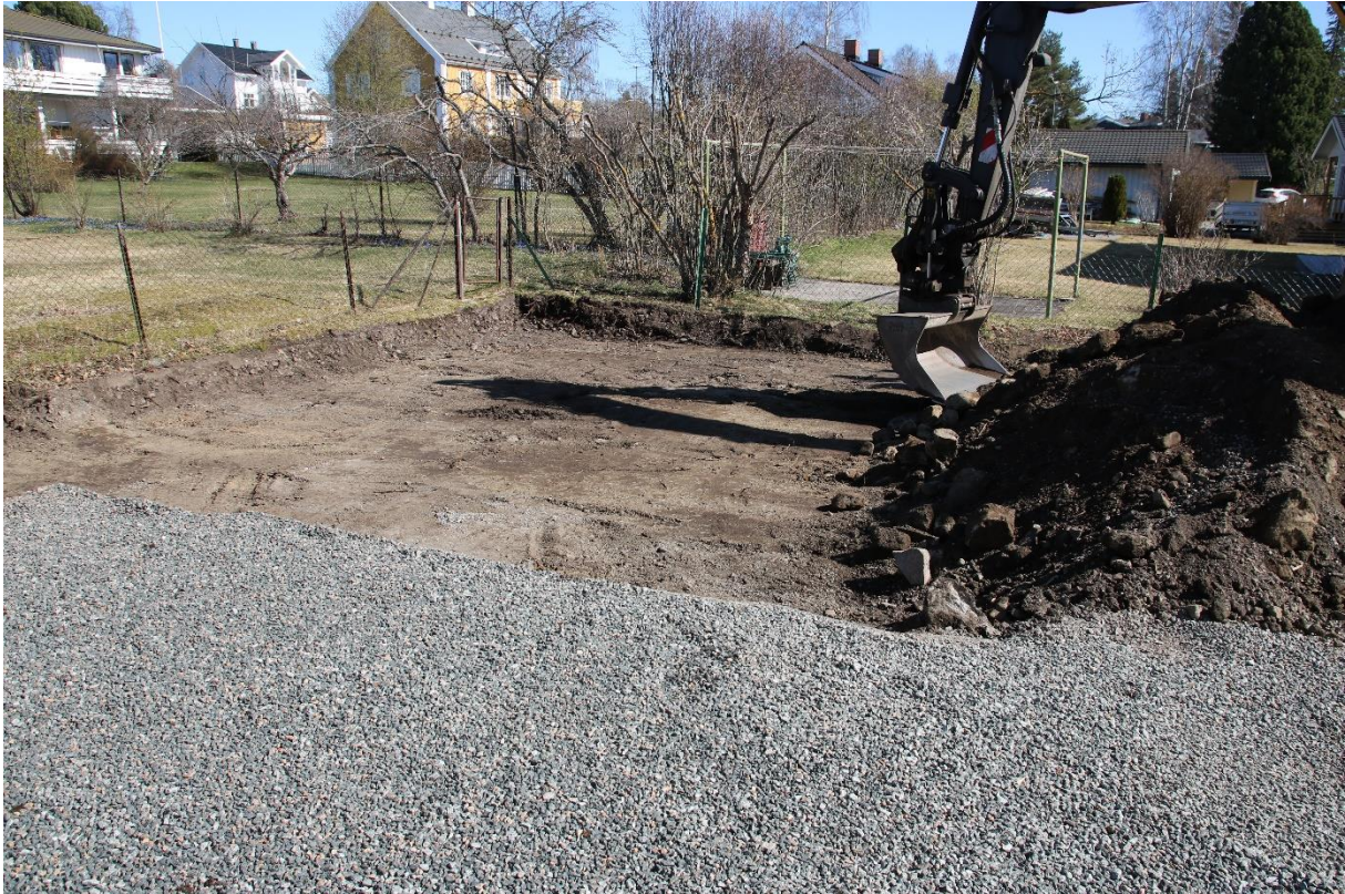
Figur 3: Graving av gropen for nytt fundament ble påstartet i den nordre delen av tiltaksområdet. Sett mot nordøst. Foto: Cf53863_NIKU_06.
