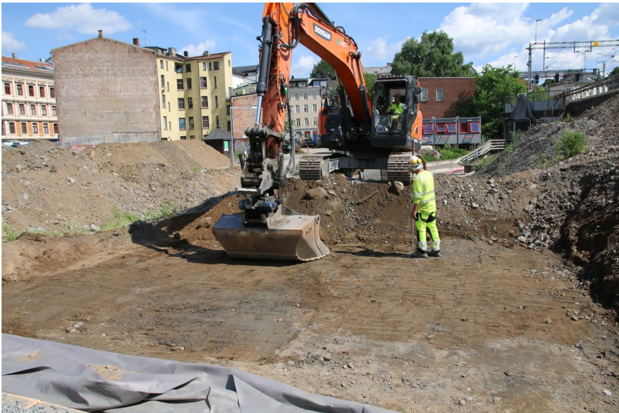
Figur 6: En av seksjonene til byggegrop for takoverbygg på Spor -1 under gravearbeidet. Grå leire kunne observeres under den gule oppfyllingssanden. Sett mot øst. Foto: Cf53908_NIKU_33.
