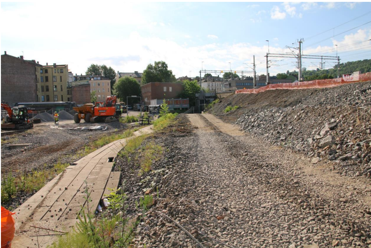
Figur 4: Tiltaksområdet før oppstart av gravearbeidene. Hovedbanen kan sees til høyre på bilde, overfor skråningen. Sett mot øst. Foto: Cf53908_NIKU_05.
