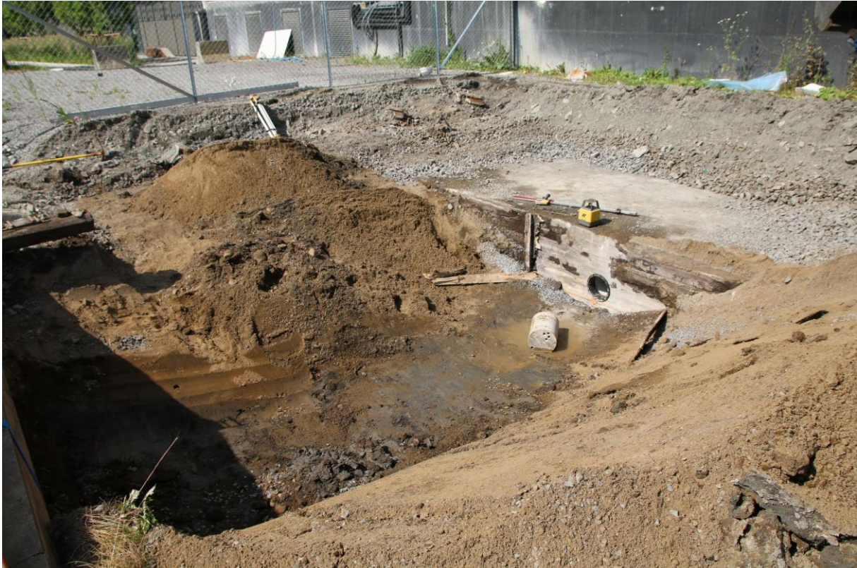
Figur 8: Grøft for overvannsledning lengst nord inn mot kulvert for Hovinbekken, som er synlig på bildet. Sett mot nord. Foto: Cf53908_NIKU_45.
