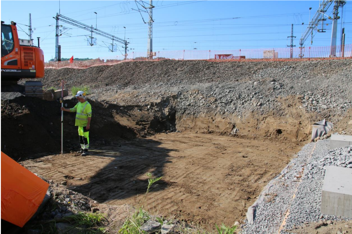
Figur 7: Eksempel på type masser som kunne observeres i området, med den gule sanden synlig i gravskråningen inn mot Hovedbanen. Sett mot sør. Foto: Cf53908_NIKU_30.
