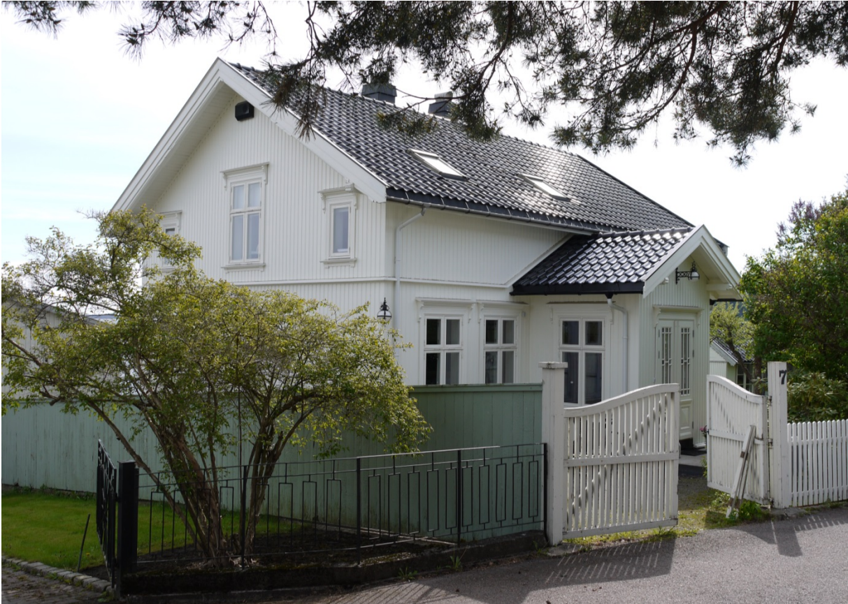
07020101018: 56 % av de undersøkte SEFRAK-bygningene i Holmestrand kommune er endret. For bolighusene er andelen høyere (62 %). 22 % av boligene har mindre volumendringer, som dette inngangspartiet. Foto: ÅD/NIKU 2014
