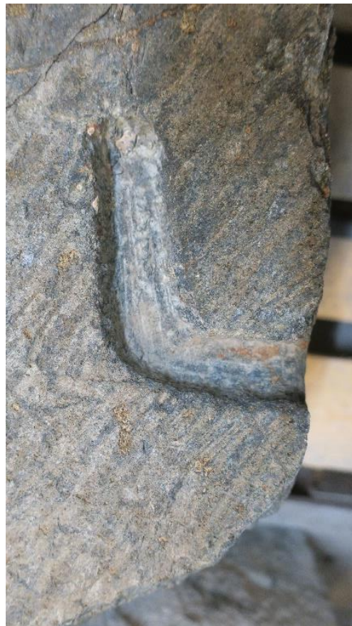
Figur 16. Portalstein med hengselspor. Foto: Ø. Ekroll, NDR.
