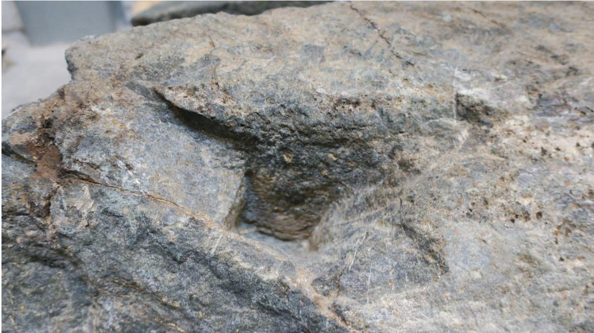
Figur 17. Kilespor i bakre del av portalstein. Foto: Ø. Ekroll, NDR.
