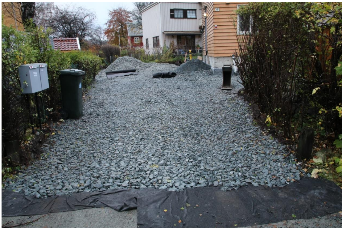
Figur 9. Området er ferdig gjenfylt med grus. Da62681_116.
