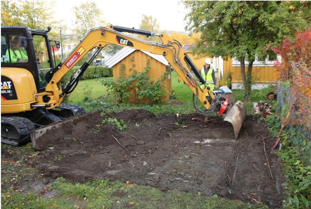
Figur 22. Avdekking av utgravningsområdet. Sett mot NV. Da62681_001.
