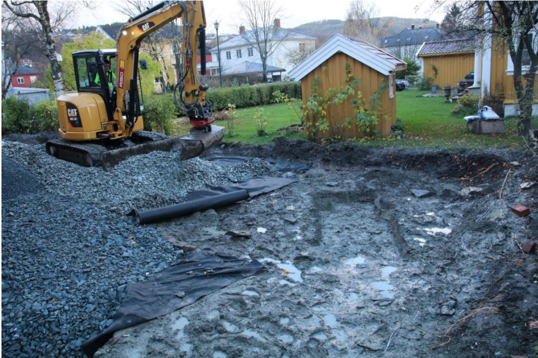
Figur 8. Området fylles igjen med grus. Fiberduk ble lagt i bunnen. Sjakt gravd gjennom dyrkingsleira er synlig. Da62681_113.
