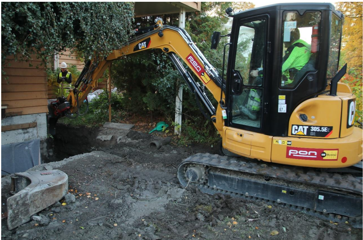
Figur 10. Graving av dreneringsgrøft 2. Da62681_025.
