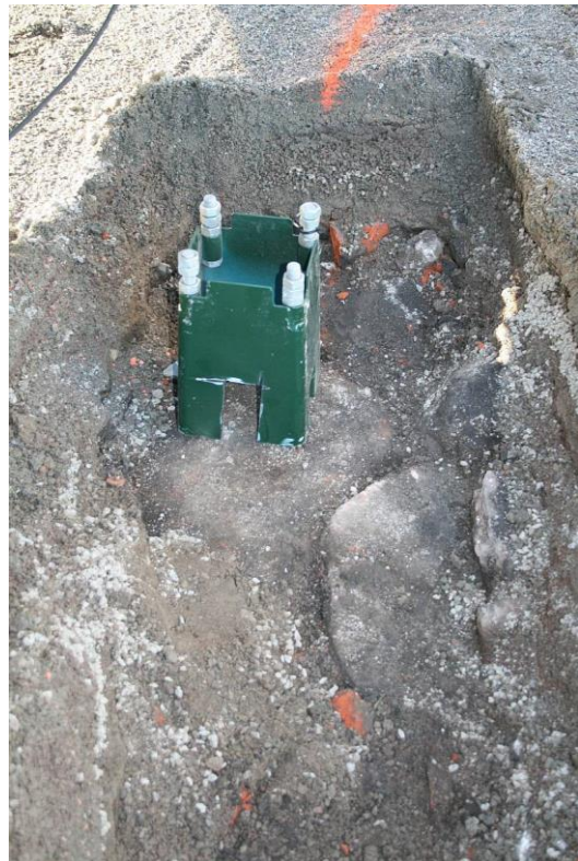
Plassering av fundament til lyskaster, over K1. Foto mot nordvest.
