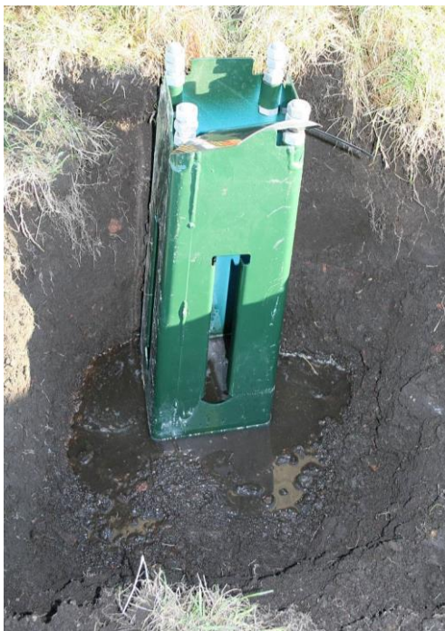
Fundament 4. Foto mot nordøst.
