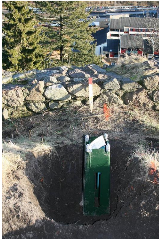
Fundament 2 på østsiden av tårnet. Foto mot øst.
