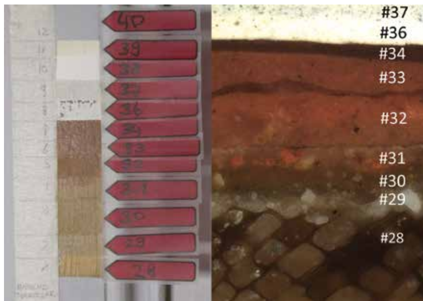
Fig. 6: Til venstre: Farge-trapp på brystning, Hafslund hovedgård. Nummerering på pilene refererer til hhXRF-målingsnumre i tabell i figur 7 (kolonne A). Til høyre: Tverrsnitt fra materialprøve av samme bygningselement. Nummerering refererer til avdekkede felt på farge-trapp og til målingsnumrene i tabellen i figur 7. (Foto t. v.: NIKU/Kaun 2014; Foto t. h.: NIKU/Kaun 2011)
