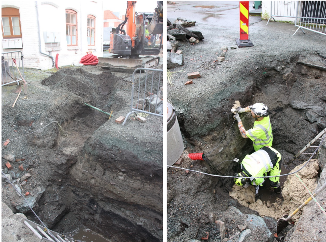
Fig. 2.12 Sjakt 3/miljøprofil 3. Hullet for kummen og forsegling av sensorene. Da62837_048 og Da62837_071
