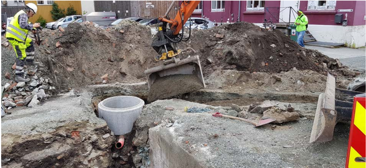
Figur 5.5: Montering av kum og trekking av rør ved miljøprofil 2 i sjakt 2
