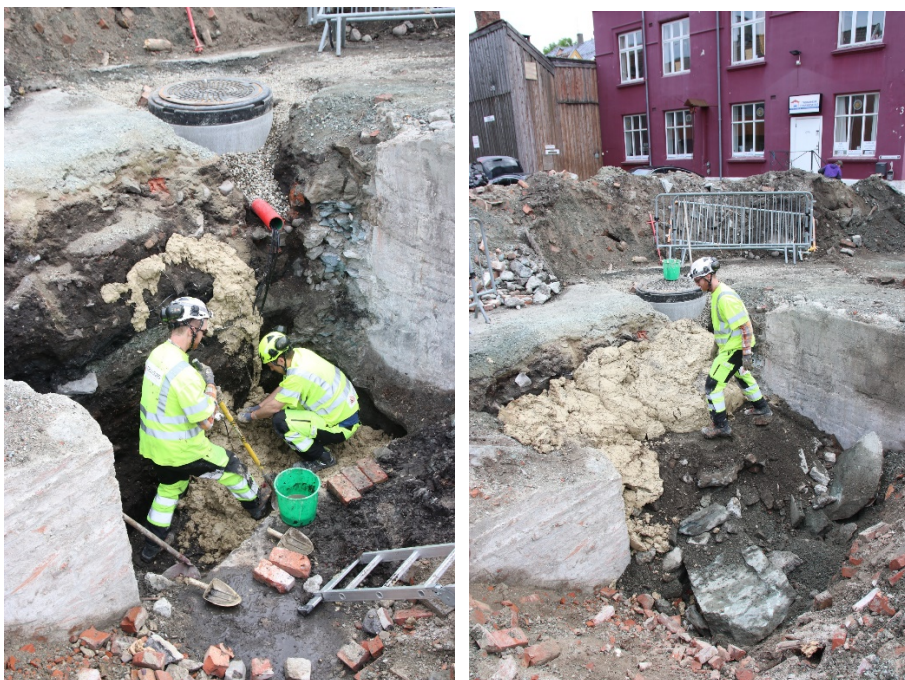
Fig. 2.6 Forsegling av miljøprofil 2 med leire og igjenfylling av sjakt 2. Sett mot SØ. Da62837_060 og Da62837_062
