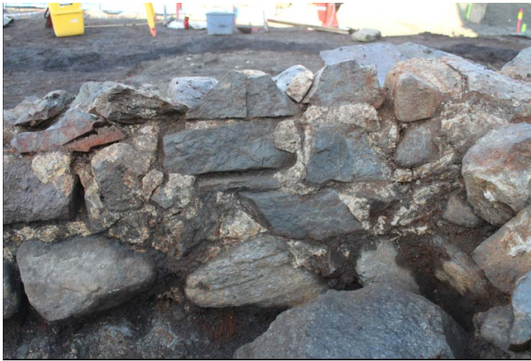
Figur 4: parti av søndre murliv hvor det fremdeles var intakt mørtel i fuger samt rester av murpuss.
