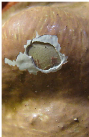
Detalj fra prekestolen, under haken på figur på nedre venstre side, fag 5. Her er det synlig at 1928-oppmalingen er meget lik den opprinnelige blå karnasjonen. Mellom disse sjiktene er et tykt lag hvitmaling fra 1895 synlig.
