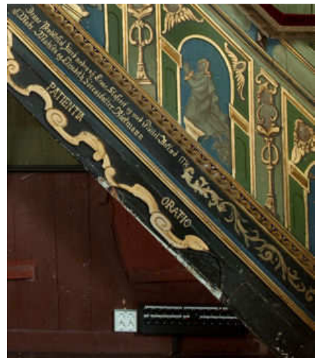
Detalj av trappevangen, mekaniske skader i nedre del
