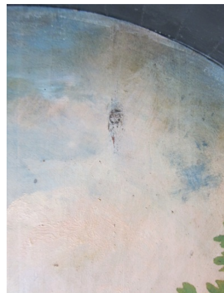
Foto 6: Kvist i panelbordet var synlig gjennom malinglaget. Foto tatt før rensing og retusjering 2015.
