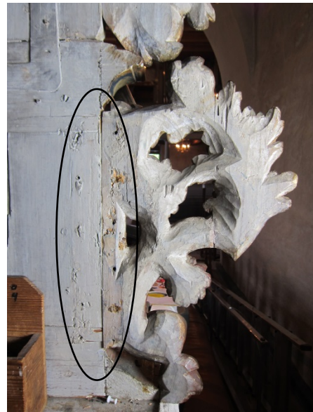
Foto 2: Baksiden etter remontering. Her sees hull fra spiker eller skruer etter en opprinnelig lask som har holdt nedre vinge fastmontert til altertavlen.
