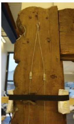
Nytt oppheng ble montert.
