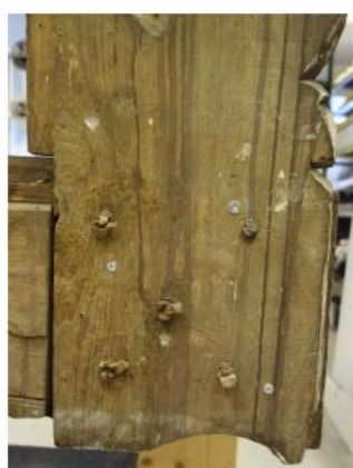
Rammehjørnene ble sikret og strammet med skuer.
