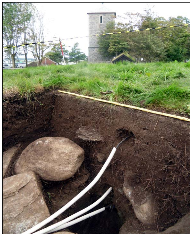
Innstallering av sonder aug 2011 ved Gravhaug
