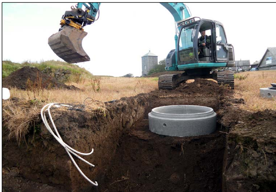
Innstalling av sonder og kum ved Dyrket mark
