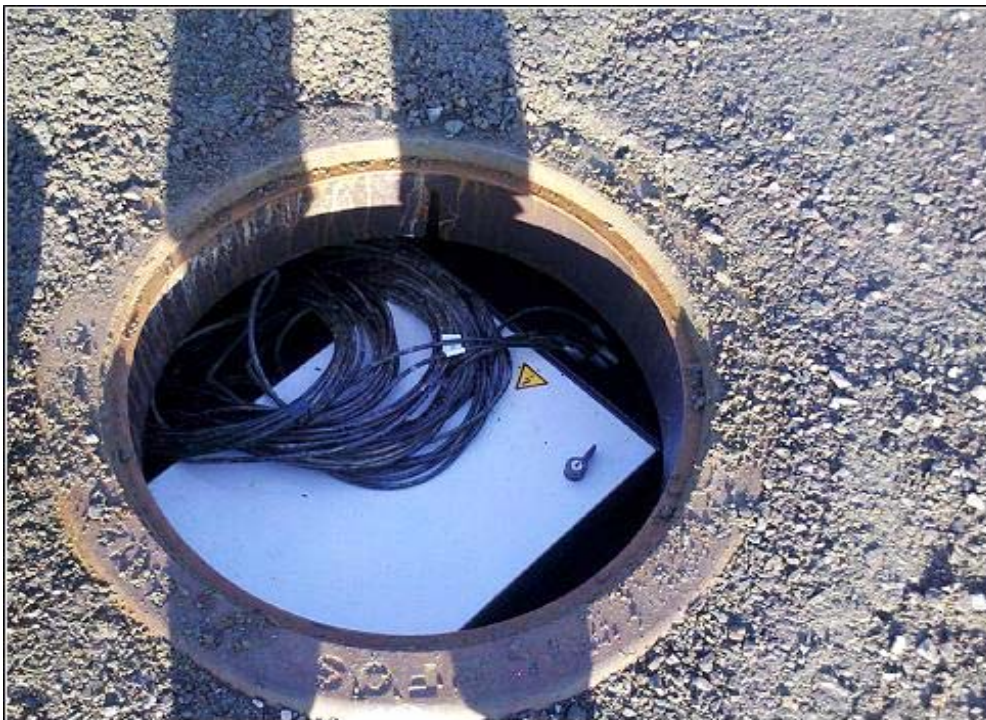
Innstallering av kum med logger ved parkeringsplass
