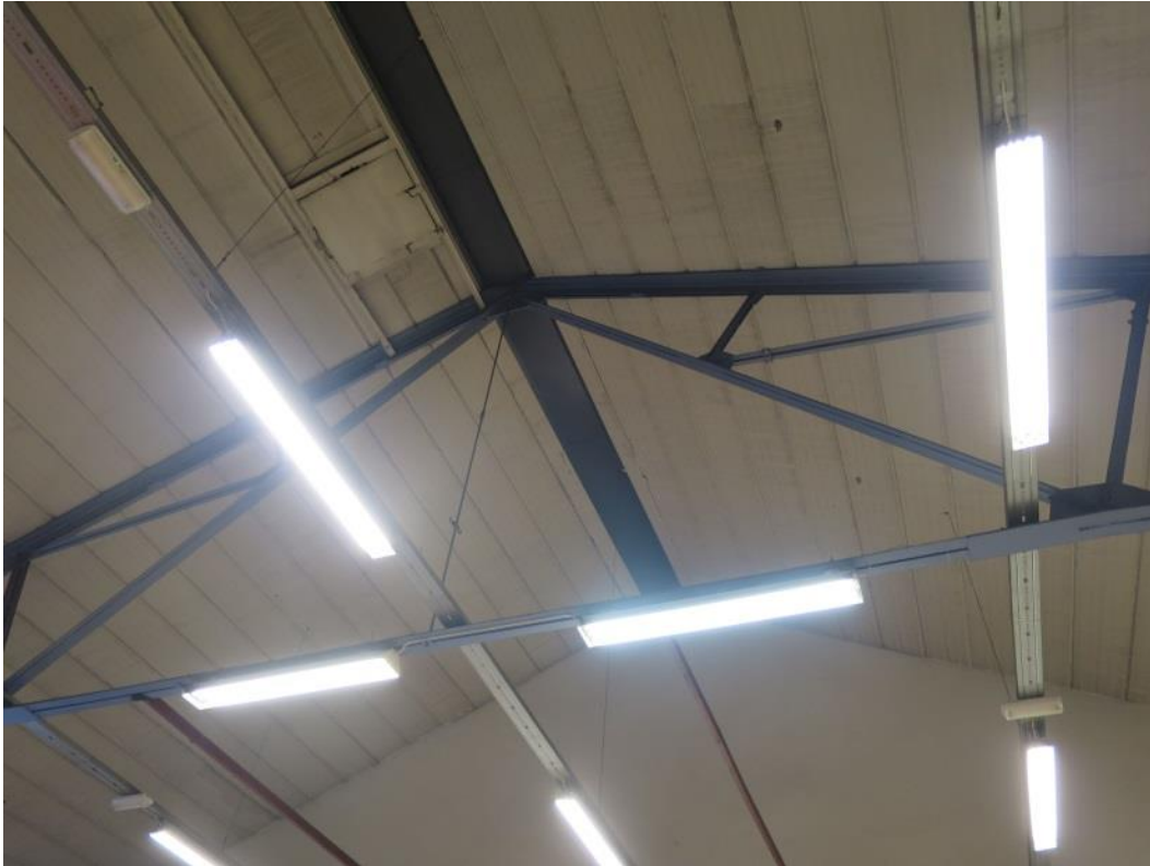
Figur 31 Original takstol, detalj foto: NIKU
