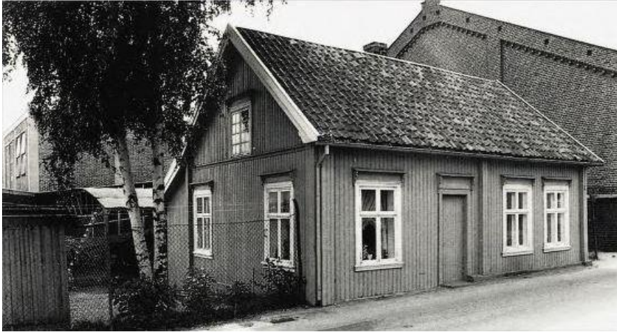
Figur 8 Brager papirfabrikk i flukt med gatelivet og den eldre bebyggelsen – på venstre side Landfalløya 11 (senere nr 2, revet), kilde: Drammen – det var en gang
