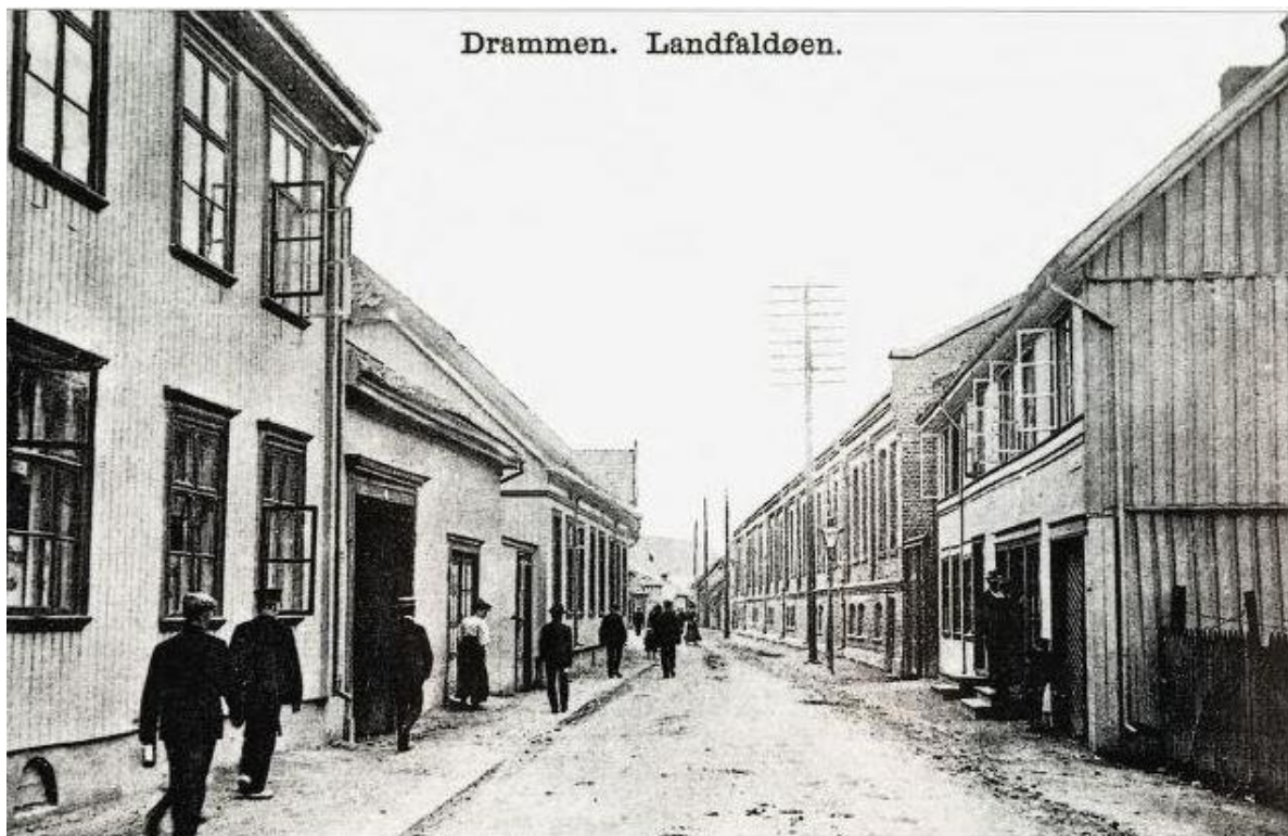
Figur 7 Landfalløya - på høyre side Brager papirfabrikk. Fabrikk ligger i flukt med gateløp og tett på nabobebyggelse. På venstre side Kiøsterud-gården fra 1839 i Landfalløya 22 med lavere sidefløy (revet 1956). Videre skimtes Pettersgården i Landfalløya 24. På høyre side Landfalløya 21, kalt kaføgården (senere revet). kilde: Drammen – det var en gang, 1994.
