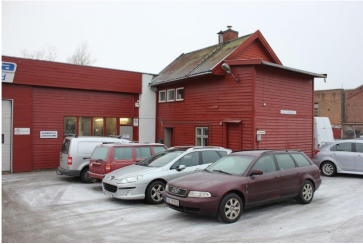
Figur 41 Landfalløya 1. Her kan det skjule seg gamle bygningskonstruksjoner bak nyere panel. Landfalløya 1 har lav verneverdi i kommunens kulturminneregister, men er registrert som et objekt som må undersøkes. Foto: NIKU
