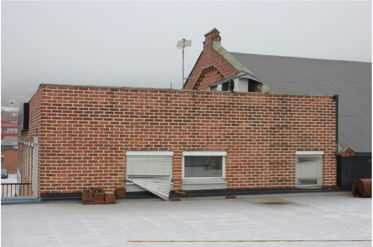
Figur 21 Tilbygg 1955, fra takterasse påbygg 1980-tallet, foto: NIKU
