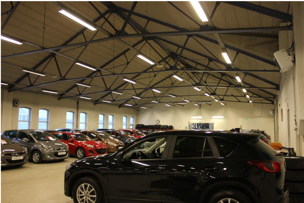
Figur 30 Maskinhallen frå 1907 med opprinnelig tak-konstruksjon i stål ,foto NIKU
