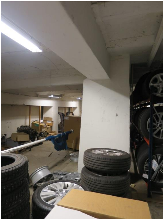
Figur 34 Konstruksjon under hallen, 1.etasje, foto: NIKU
