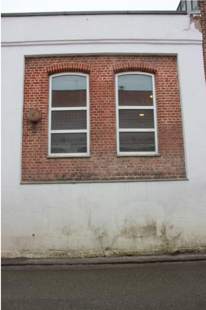
Figur 15 Vinduer mot Landfalløya, foto: NIKU
