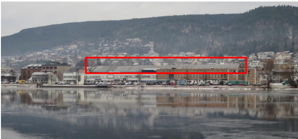
Figur 12 Brager papirfabrikk sett fra Drammselva (Markert: takform til opprinnelig fabrikk 1906/1912)foto: NIKU
