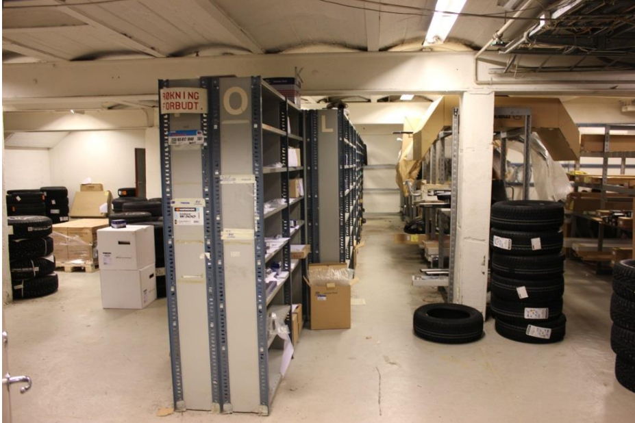
Figur 33 Støpte kappehvelv samt piler og dragere i stål for å bære tyngden av PM-maskinene. Maskinene ble plassert i andre etasje, etter et amerikansk prinsipp, foto: NIKU
