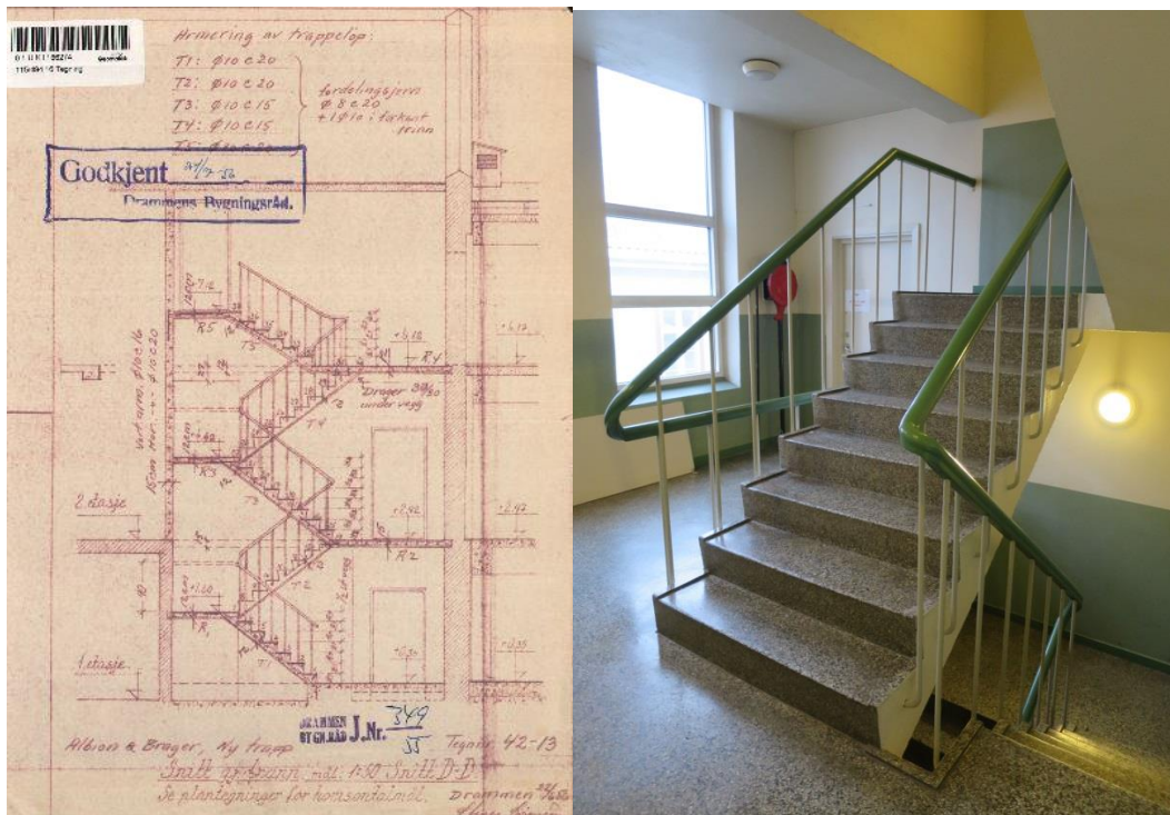
Figur 32 Trapperom i vestlig del, innbygget i hallens vestre del i forbindelse med påbygget i 1955, foto: NIKU
