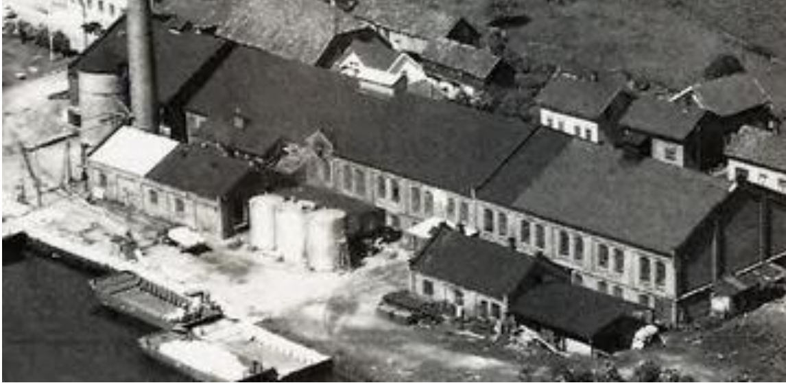
Figur 23 Fasade mot syd opprinnelig fabrikk-bygning 1906/1912, foto: Drammen – det var en gang, utgitt 1994
