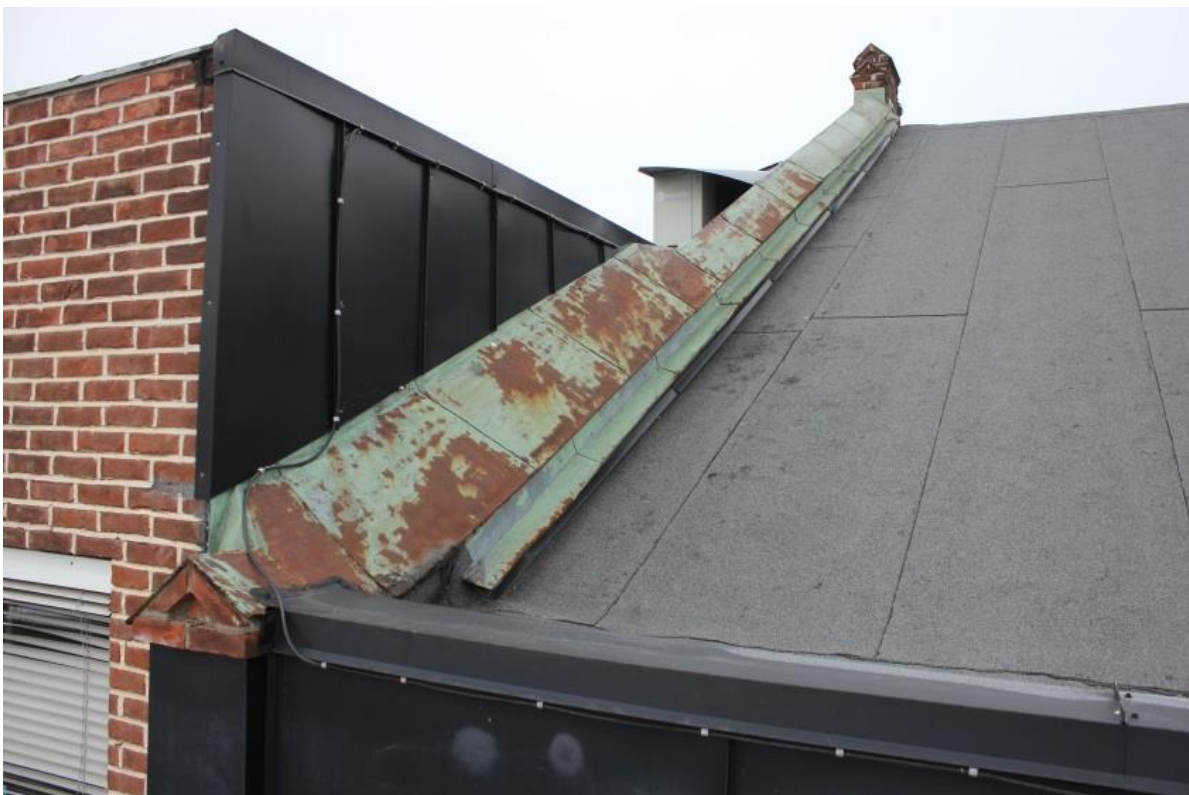
Figur 22 Takdetalj original vestfasade, foto: NIKU
