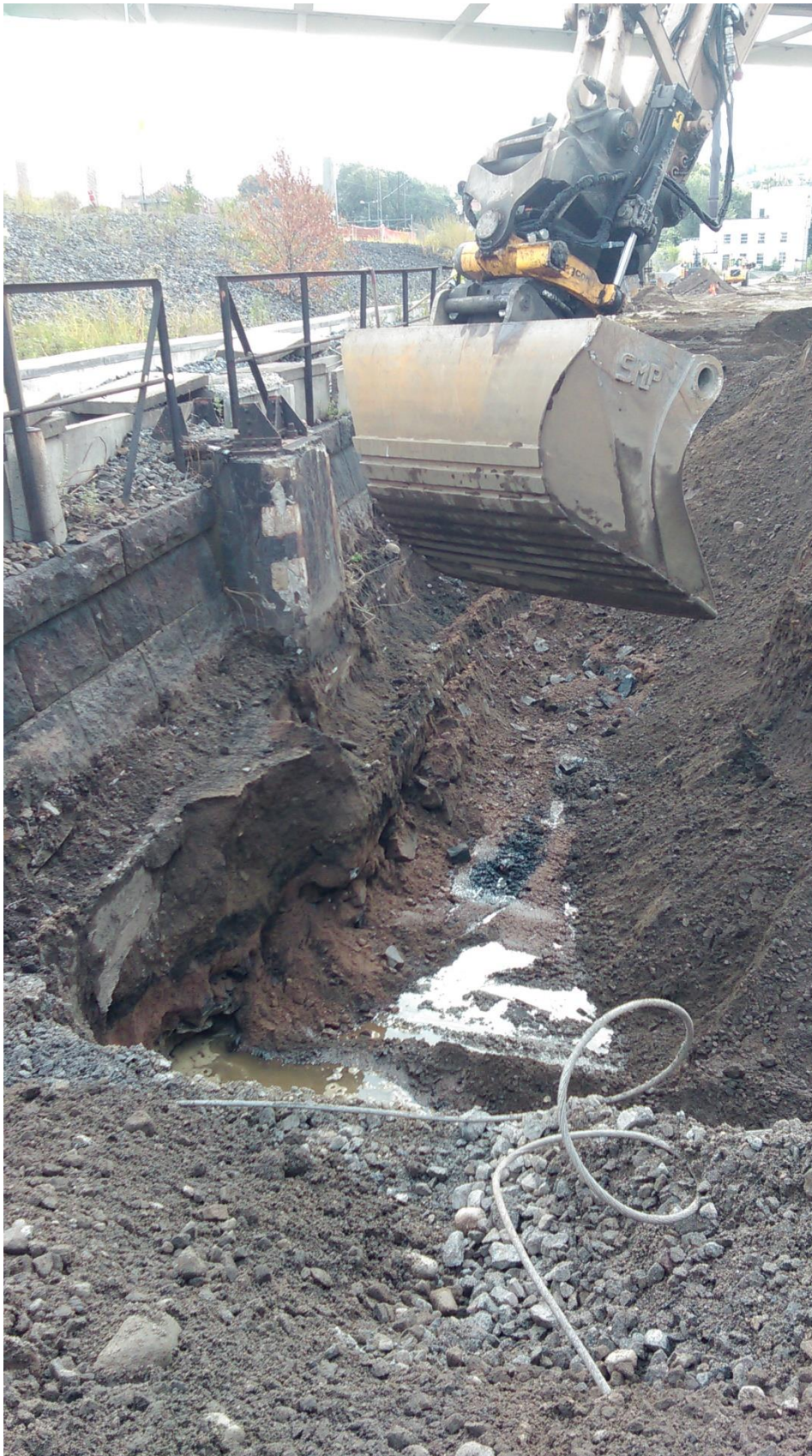
Figur 4: Grøftegraving inntil muren i nordøstre spuntlinje. Sett mot øst. Foto: Maria Sture, NIKU (Cf35157_NIKU_0006).
