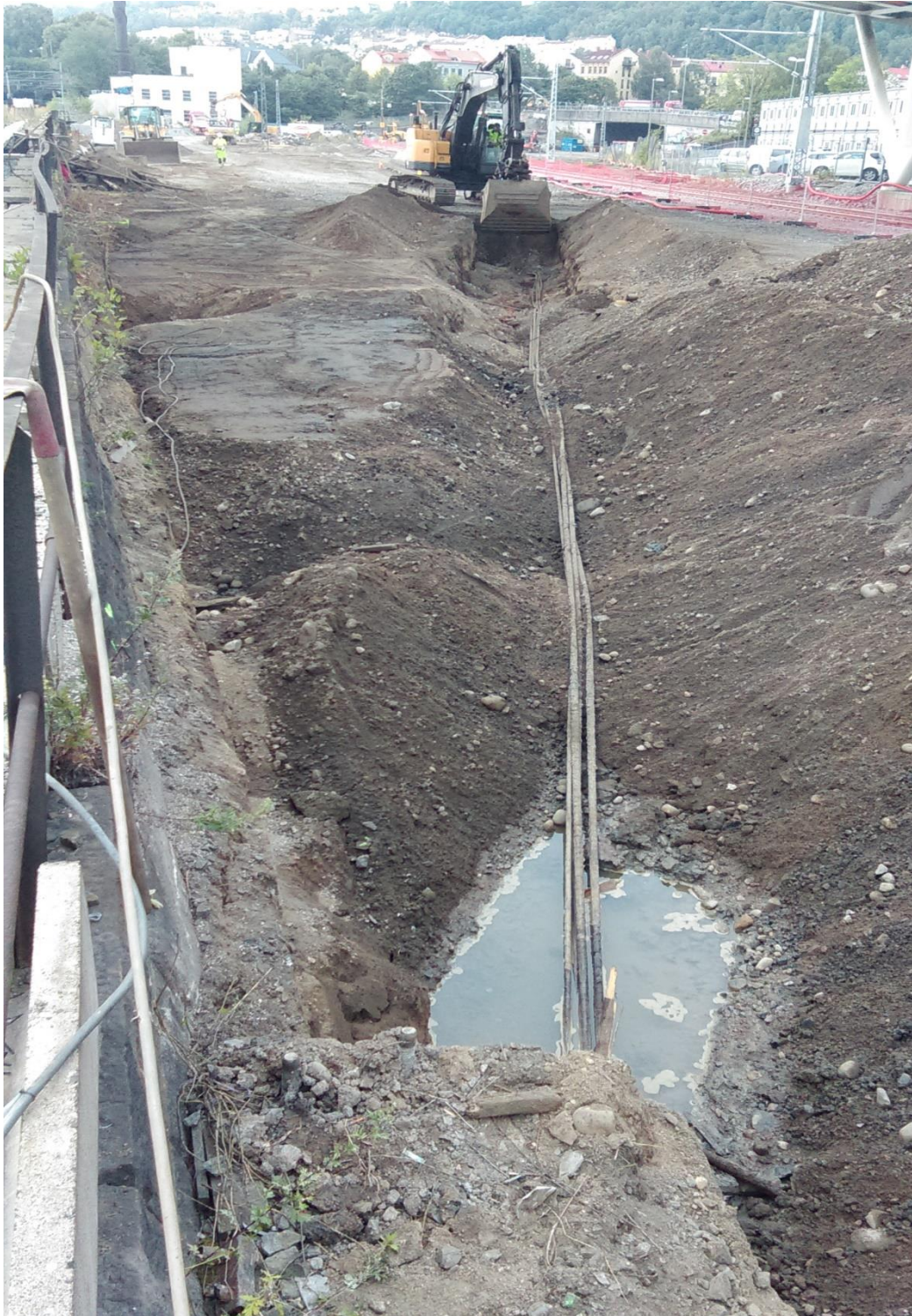
Figur 5: Kabler og vann ved graving av grøft. Sett mot øst. Foto: Maria Sture, NIKU (Cf35157_NIKU_0004).
