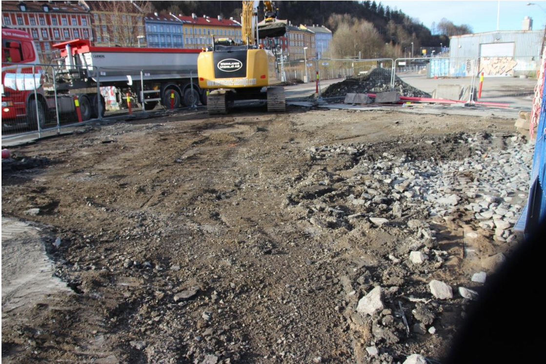
Figur 12: Grøft til pressegrup før oppstart av gravingen. Sett mot sørvest. Foto: Cf35143_NIKU_0001.
