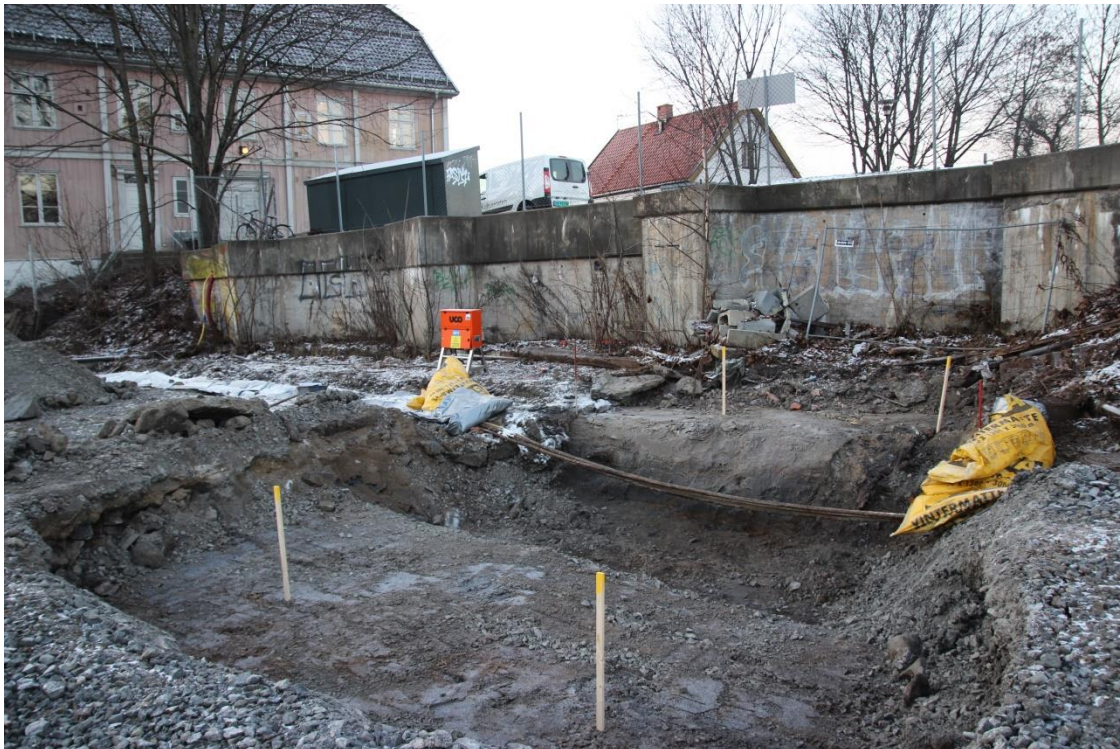
Figur 7: Mottaksgrop ferdiggravd etter tømning etter rettevedtak. Stikkene markerer området som skal spuntes. Sett mot nordvest. Foto: Cf35143_NIKU_0080.
