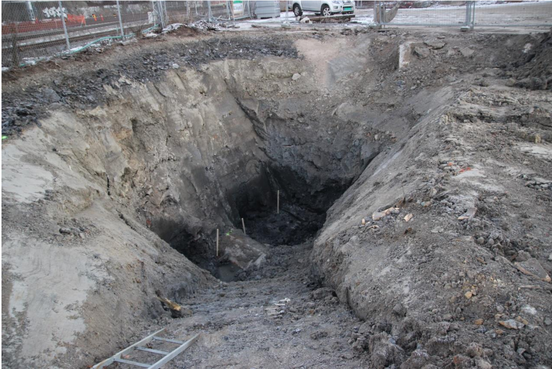
Figur 11: Pressegrøfta gravd ned til nivået til røret, som er synlig i bunnen av grøfta. Sett mot nordøst. Foto: Cf35143_NIKU_0042.
