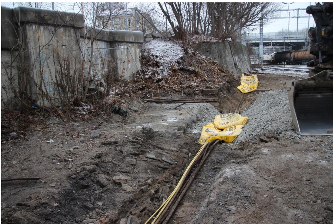
Figur 6: Mottaksgrop etter graving og igjenfylling uten arkeologisk overvåking. Sett mot øst. Foto: Cf35143_NIKU_0020.
