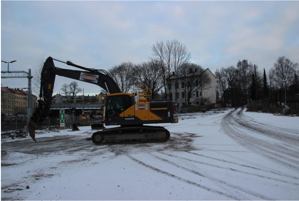
Figur 9: Pressegrøp før gravingen startet. Gravemaskinføreren har stukket ut området, og er klar til å begynne arbeidet med fjerning av asfalt. Sett mot øst. Foto: Cf35143_NIKU_0035.
