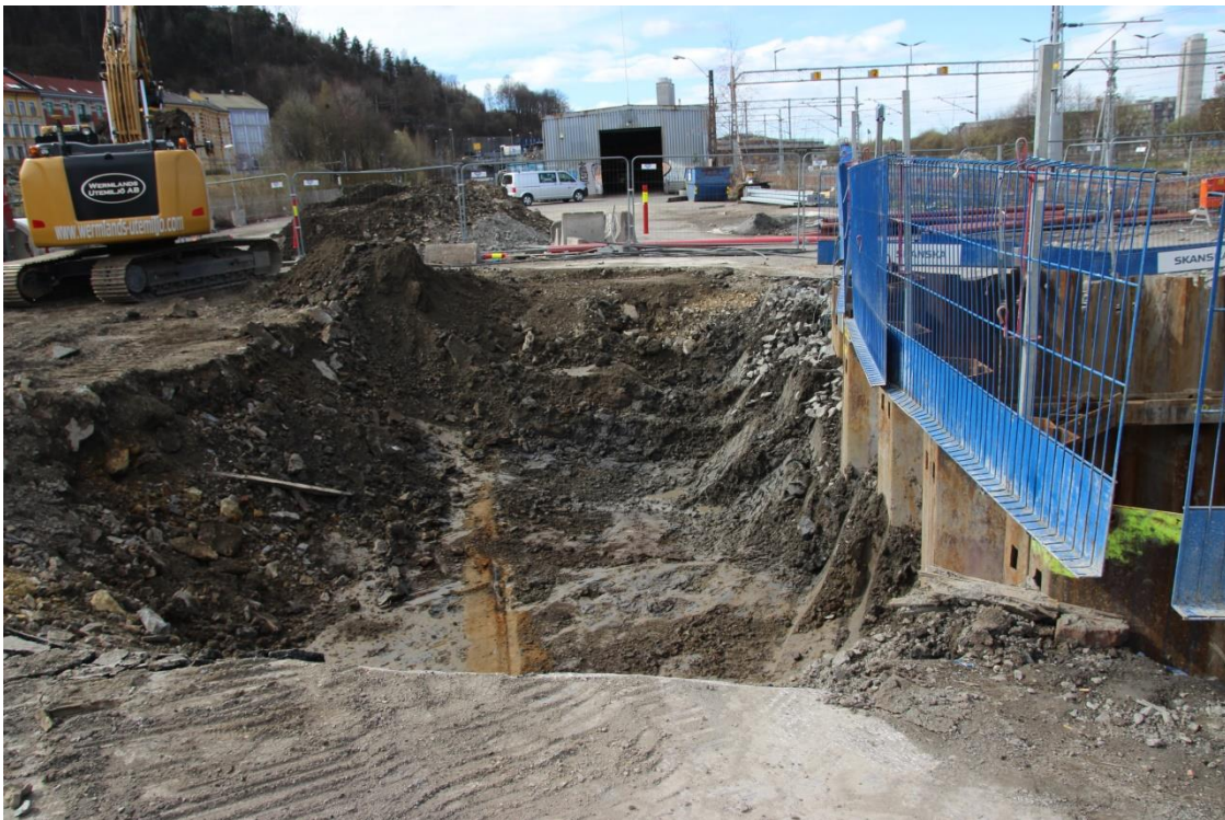
Figur 13: Grøft til pressegrup under gravearbeidet. Sett mot vest. Foto: Cf35143_NIKU_0003.
