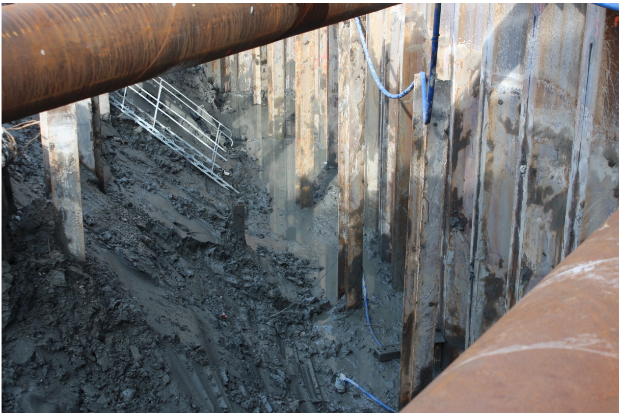
Figur 3: Oversikt, nordre del ferdig utgravd, sett mot nord-øst. Foto nr: Cf35119_NIKU_0073
