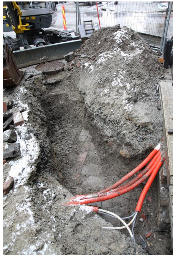
Figur 2. Østre del av grøften ved Rosenkrantzgate 3 ferdig gravd. Kabler ut fra husvegg til høyre i bildet, og betongheller over strømkabler synlig under dem. Nordvest i grøften steinmurt kum.
