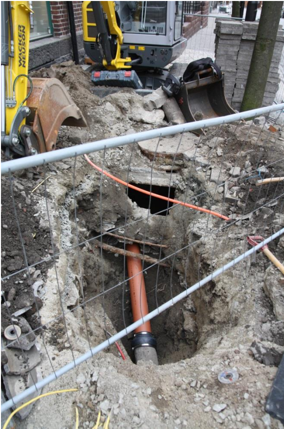
Figur 3. Vestre del av grøft ved Rosenkrantzgaten 3 ferdig gravd. Denne delen av grøften ble gravd i eksisterende trasé for overvannsledning. Bf30003_NIKU_0005.JPG
