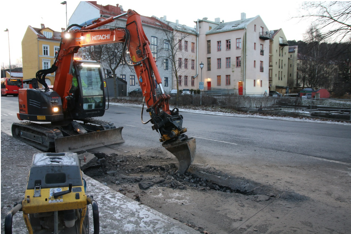
Figur 14: Prøvehull 5, pigging av asfalt. Sett mot SØ. Foto-nr: Cf53330_NIKU_0074
