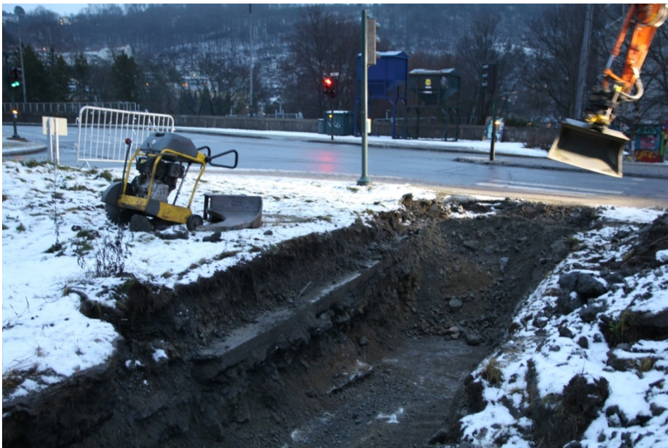
Figur 2: Prøvehull 1, arbeidsbilde. Sett mot SØ. Foto-nr: Cf53330_NIKU_0021
