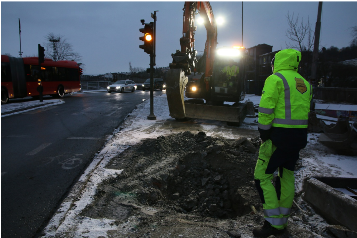
Figur 9: Prøvehull 3, arbeidsbilde. Sett mot Ø. Foto-nr: Cf53330_NIKU_0041
