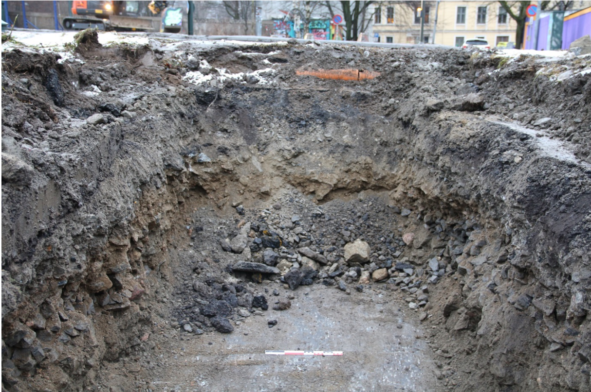
Figur 19: Prøvehull 1, ferdig grøft. Sett mot S. Foto-nr: Cf53330_NIKU_0023
