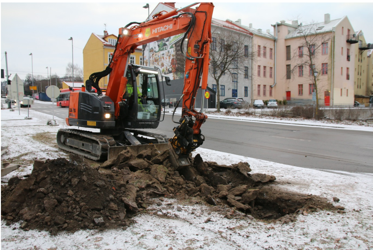
Figur 10: Prøvehull 4, arbeidsbilde. Sett mot SØ. Foto-nr: Cf53330_NIKU_0050
