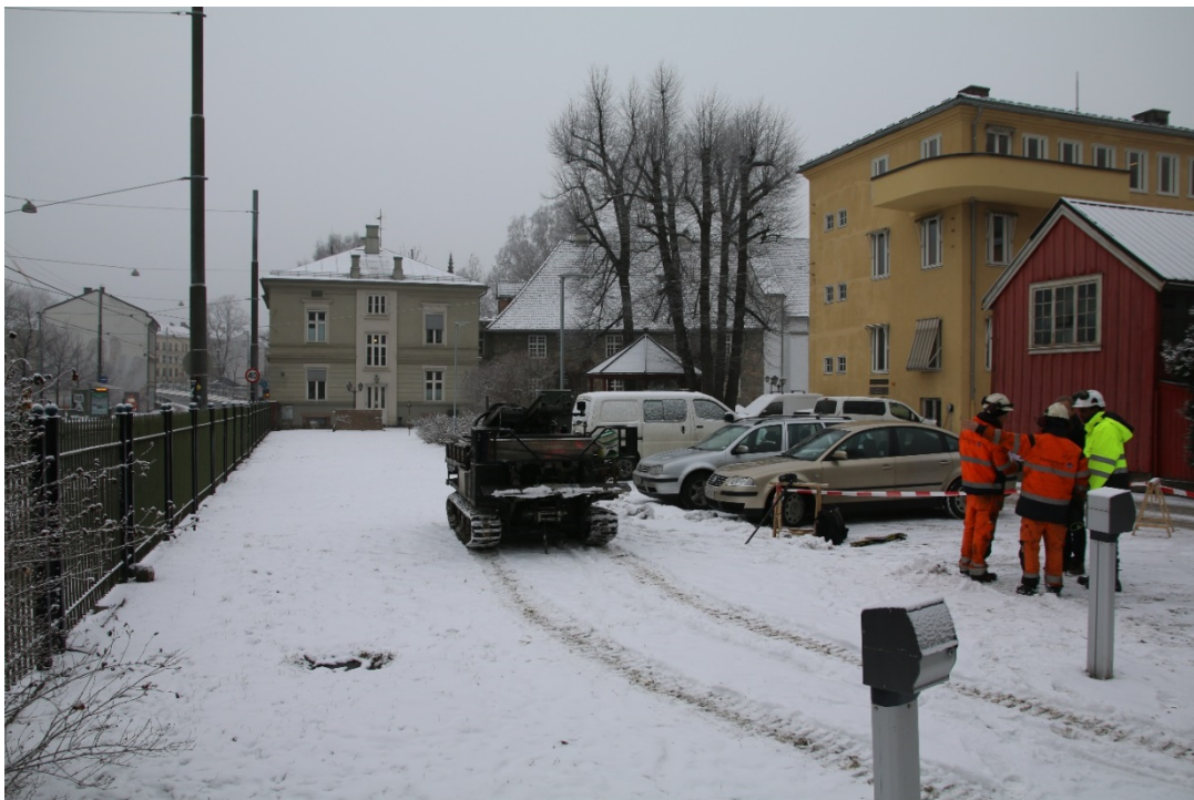
Figur 1: Boremaskinen ved borepunkt 304. Sett mot nord. Foto-nr: Cf53279_NIKU_0002
