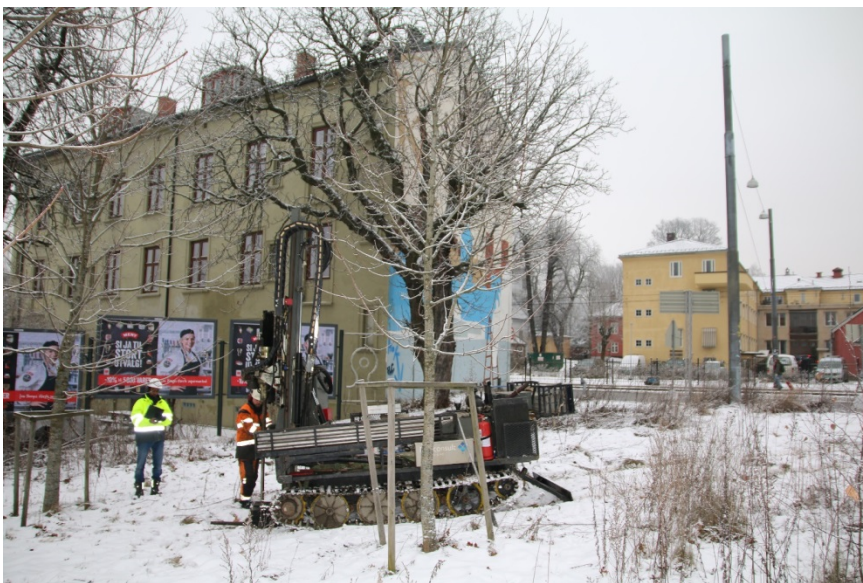
Figur 5: Borepunkt 301 ved boreriggen, nordvest for rundkjøringen. Sett mot øst. Foto-nr: Cf53279_NIKU_0015
