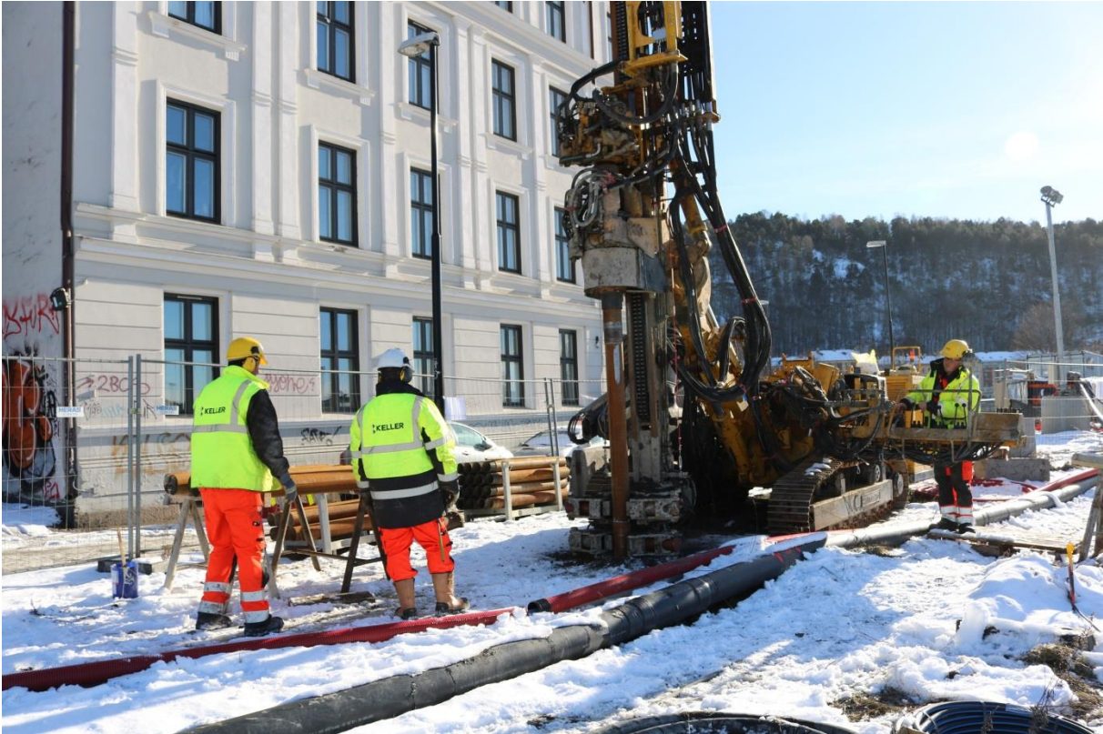
Figur 4: Boring med føringsrør på IC1.
