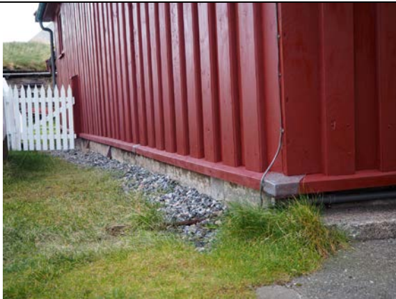
Nordsida av kirka som har fått et utbedret system for drenering.
