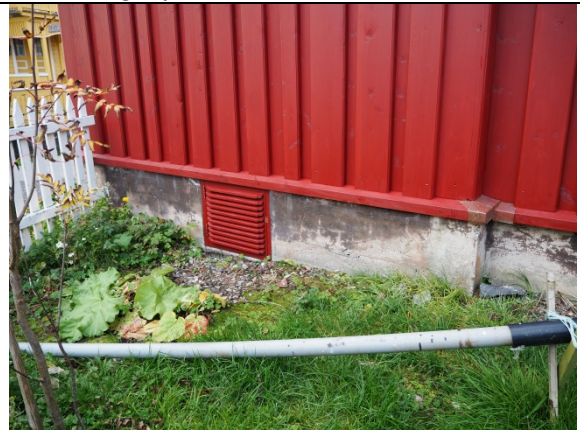
Gavl på sakristi/teknikkrom med inspeksjonsluke i grunnmuren. Vannoppsamlingen bak muren i nordøstlig del av kirken har tidligere forårsaket en dam og et fuktig klima under gulvet i sakristiet. Årsaken til dette var trolig tilsig fra terrenget utenfor kirken. Dette ble utbedret i 2001-2006.
