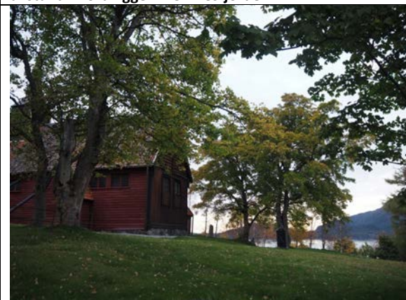
Kirkens sydvegg, østre del med kor-inngang.
