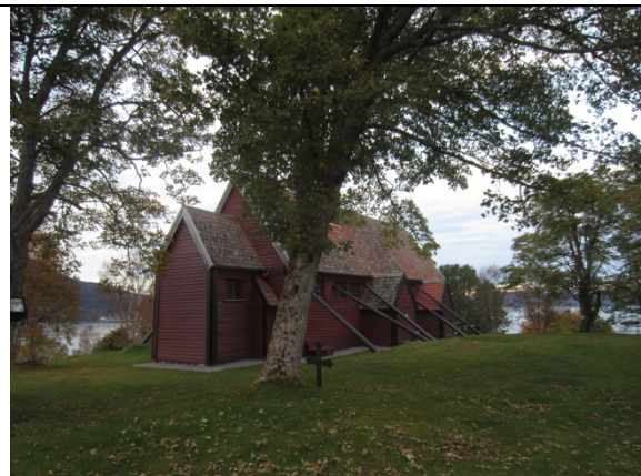
Kirken og skråstøtter sett fra sydvest.
