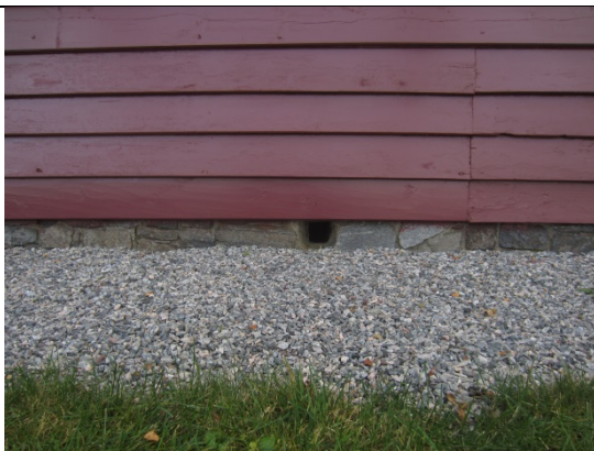
Støpt grunnmur. Åpning inn mot kjeller.
