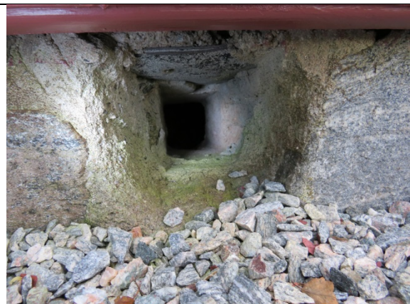
Åpning i grunnmur
