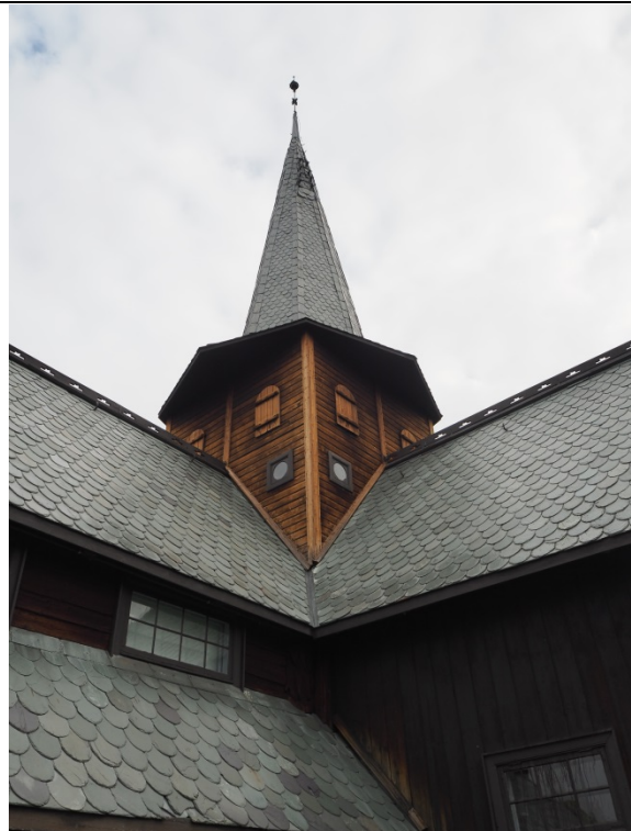
Taket er kledd med såkalt Valdreskifer. Bildet viser tårnet sett fra sydvest. Nederst til venstre er taket på svalgangen.
