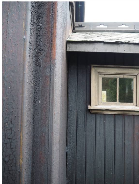
Detalj bilde av nybygget våpenhus/universalinngang på nordre siden. Noter spalten mellom veggene. Viktig å følge med å sikre tetthet i overgang mellom tak og vegg.
