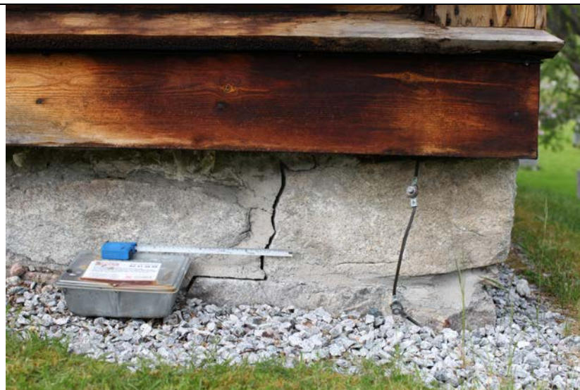
Grunnmur øst, hørnet mot syd. Sekundære sementholdige fuger
