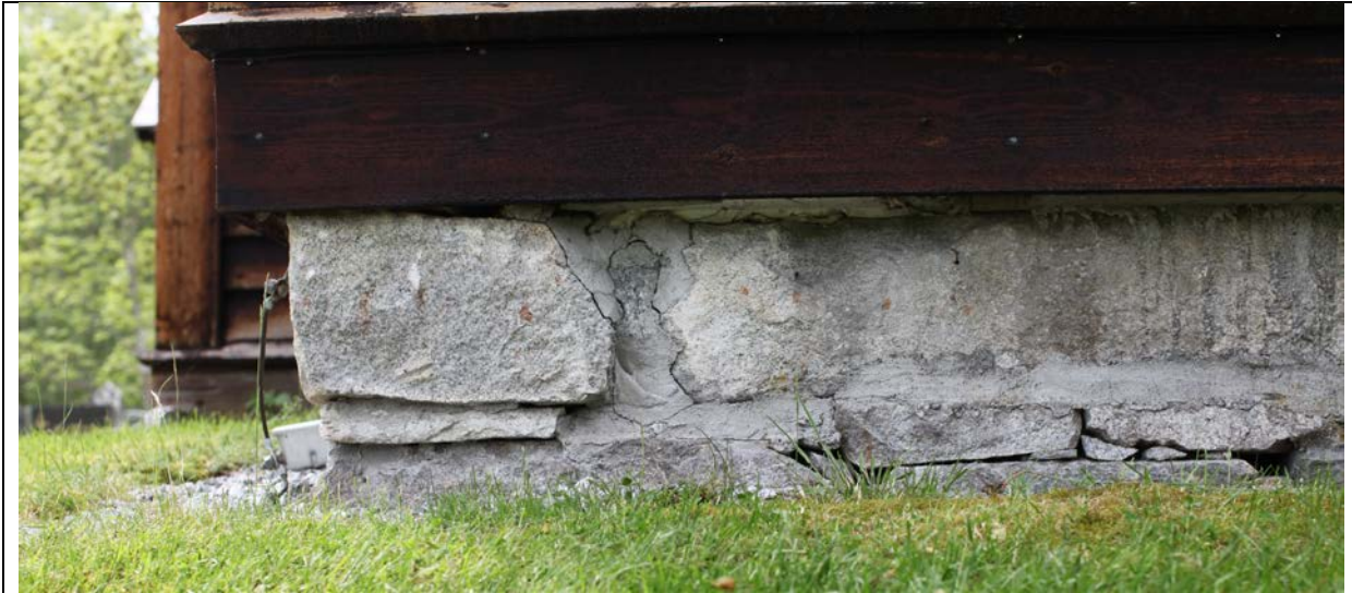
Grunnmur øst, hørnet mot syd. Sekundære sementholdige fuger
