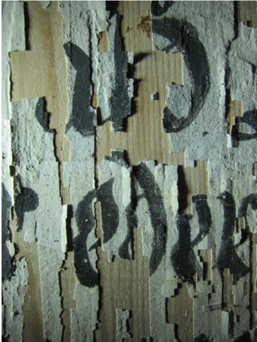
Foto 10a: Detalj av løs maling fra korskillelets vestvegg. Eksempel på limfarge som lot seg konsolidere med 3 % størlim.
