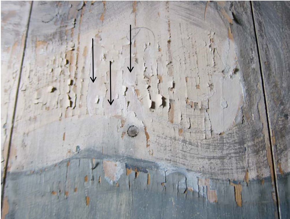
Foto 17: Detalj av taket der tre mindre retusjer i hvitt område er malt inn i skadeområdene. I tillegg har mer maling løsnet i områdene rundt.
