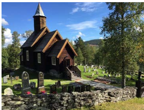
Foto 3: Sollia kirke under konserveringsarbeidet august 2016. Foto: NIKU
