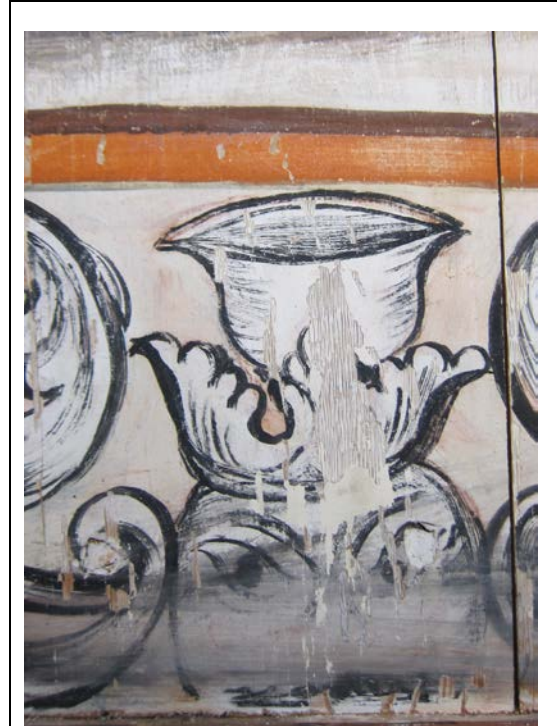
Foto 15: Detalj fra korsllets vestvegg. Eksempel på a) malingen er «subbet» ut kanskje på grunn av vann for vasking e.l. og b) retusj der konturene ikke ble fulgt ved retusjering grunnet usikkerhet for hvor linjen har vært.
