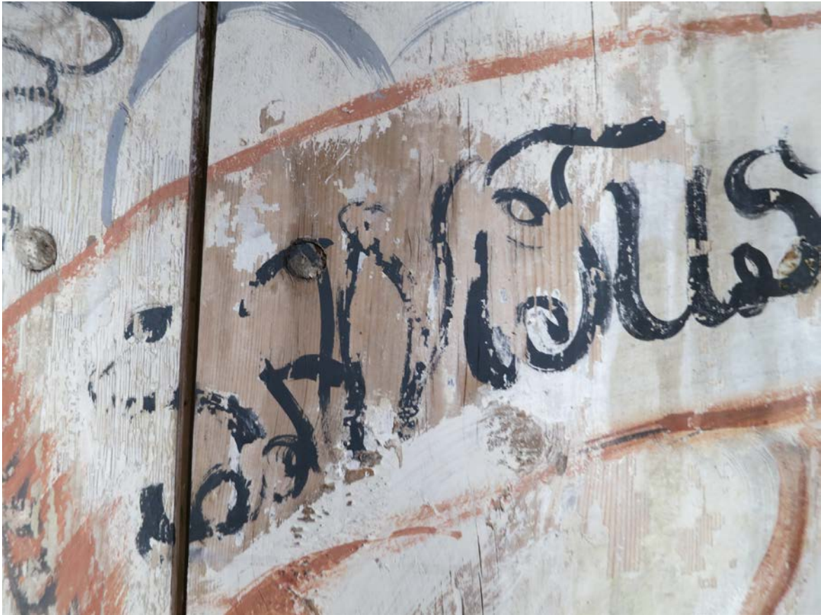
Foto 13 a: Detalj fra korskillets østvegg før retusjering. Eksempel på en mørk skade i et lyst område.
